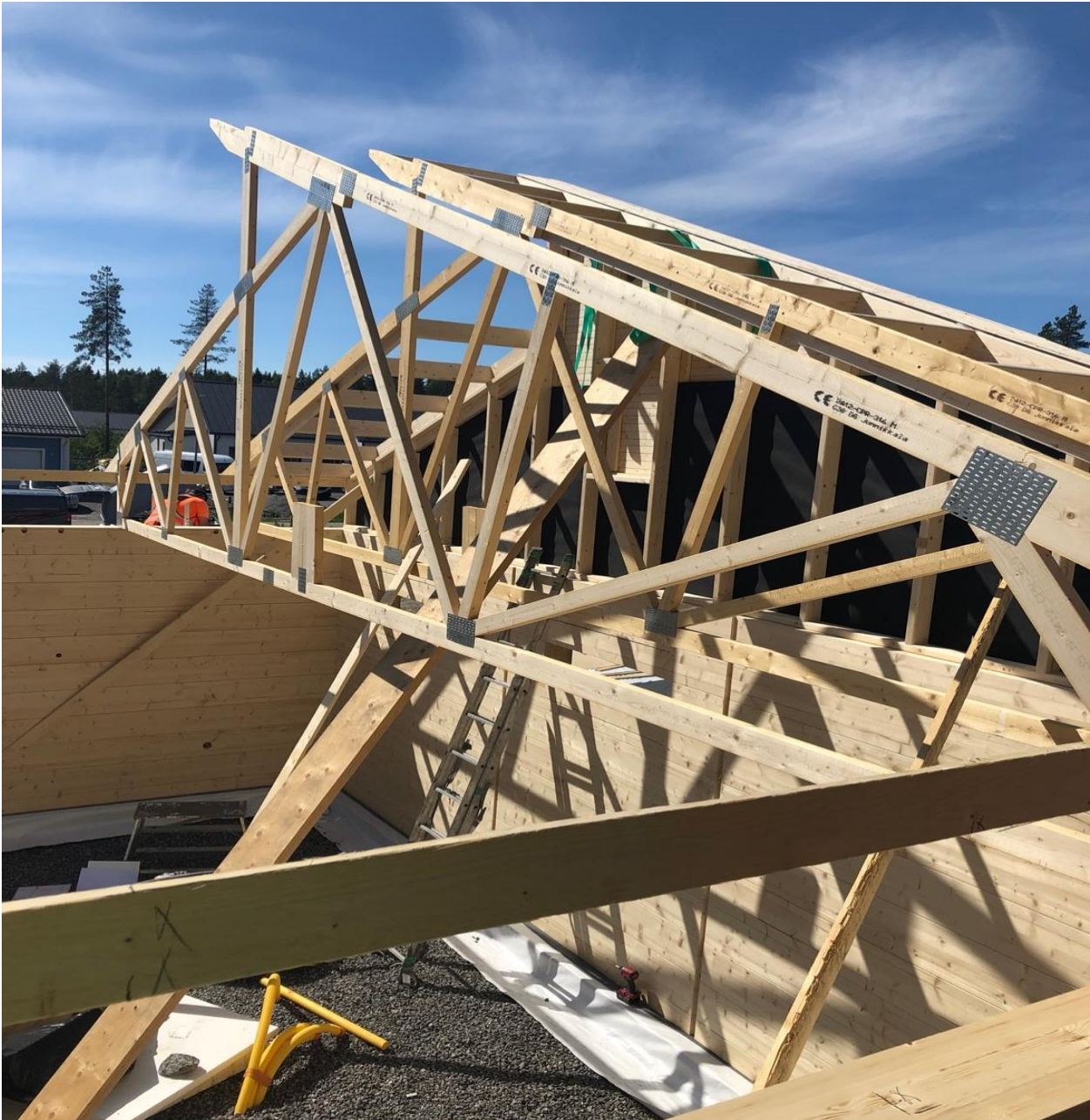
Kuva 8. Elementti nostettuna paikoilleen. (Vilhelmiina Närvä)
