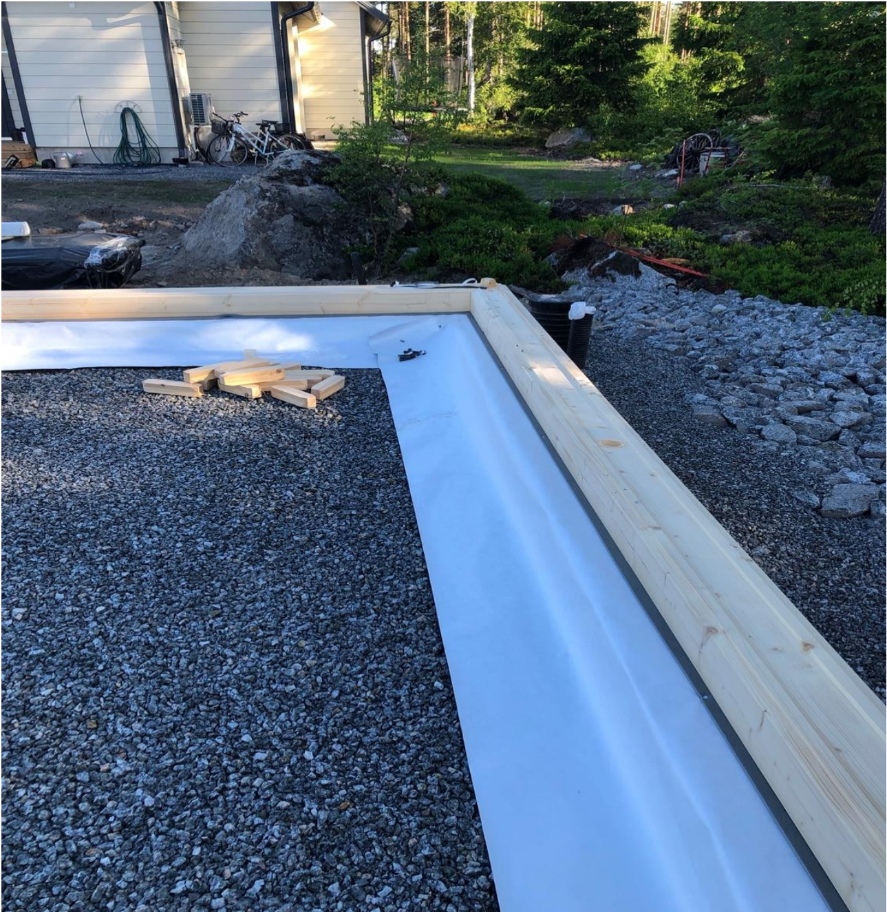
Kuva 2. Ensimmäinen hirsikerta asennettuna paikoilleen. (Vilhelmiina Närvä)
