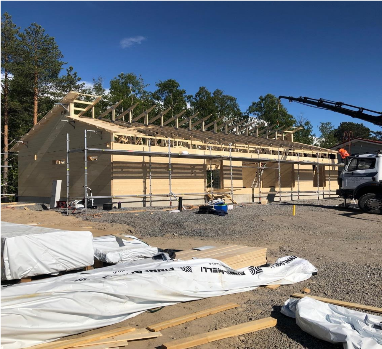
Kuva 9. Hirret, kattoristikot ja elementit asennettuina paikoilleen. (Vilhelmiina Närvä)
