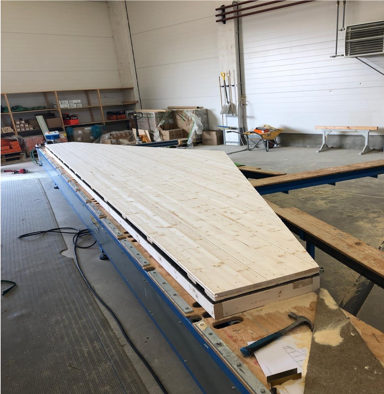
Kuva 6. Valmis päätykolmioelementti. (Vilhelmiina Närvä)
