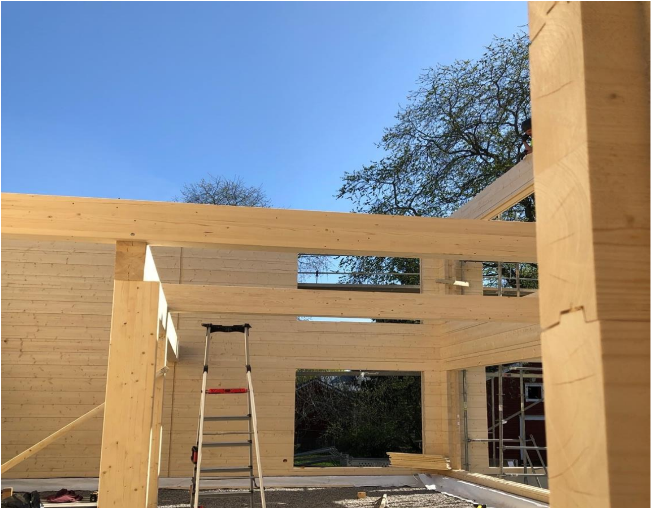
Kuva 4. Liimapuupalkkeja asennettuna paikoilleen. (Vilhelmiina Närvä)
