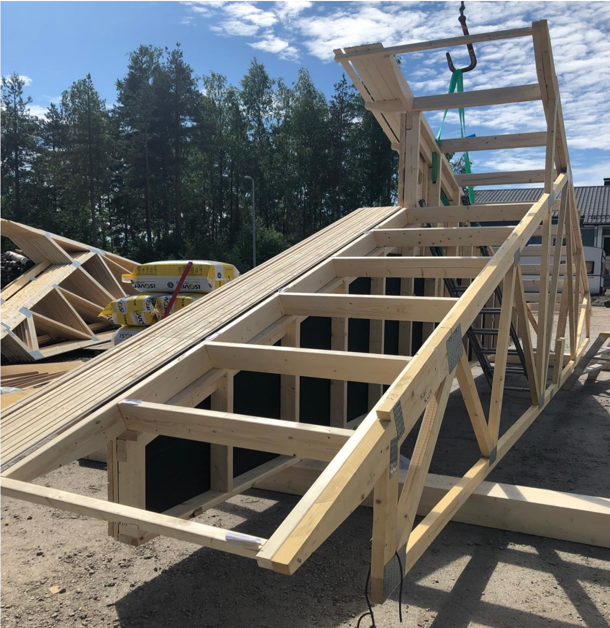
Kuva 7. Kattoristikko sekä päätykolmio- ja päätyräystäselementti kasattuina maassa. (Vilhelmiina Närvä)
