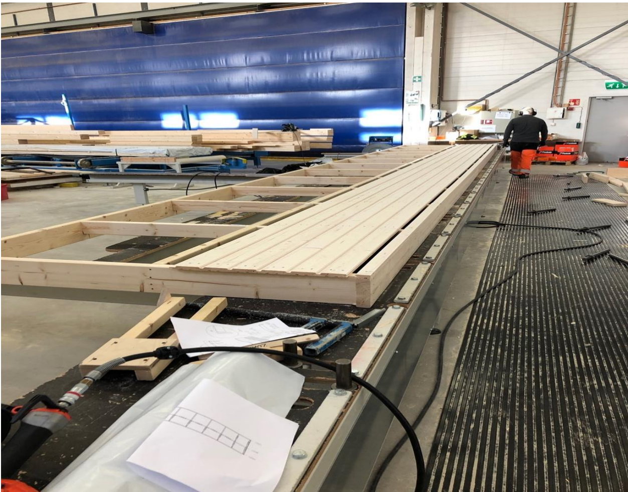
Kuva 5. Valmis päätyräystääselementti. (Vilhelmiina Närvä)
