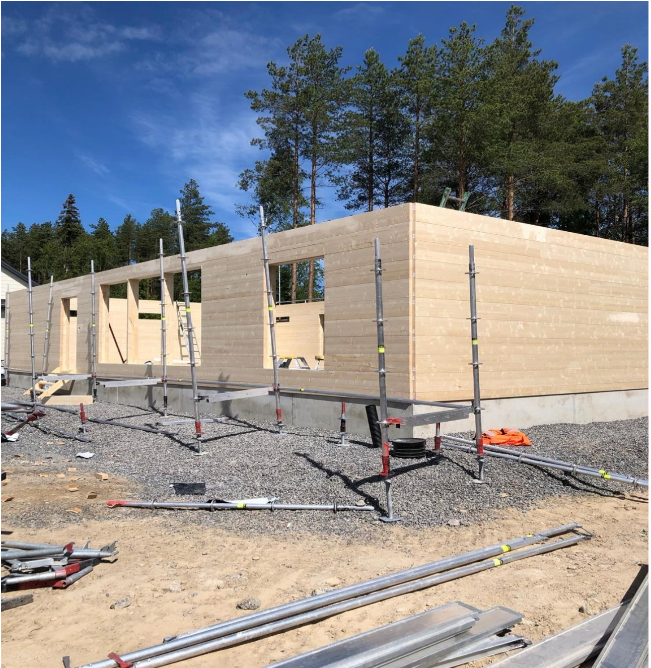
Kuva 3. Viimeinen hirsikerta asennettuna paikoilleen. (Vilhelmiina Närvä)
