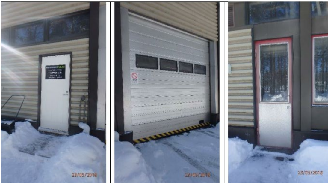
Kuva 1. Kohteen ovia. Kuva: Kuntoarvioraportti, Rakennuttajatoimisto Protiimi Oy.
