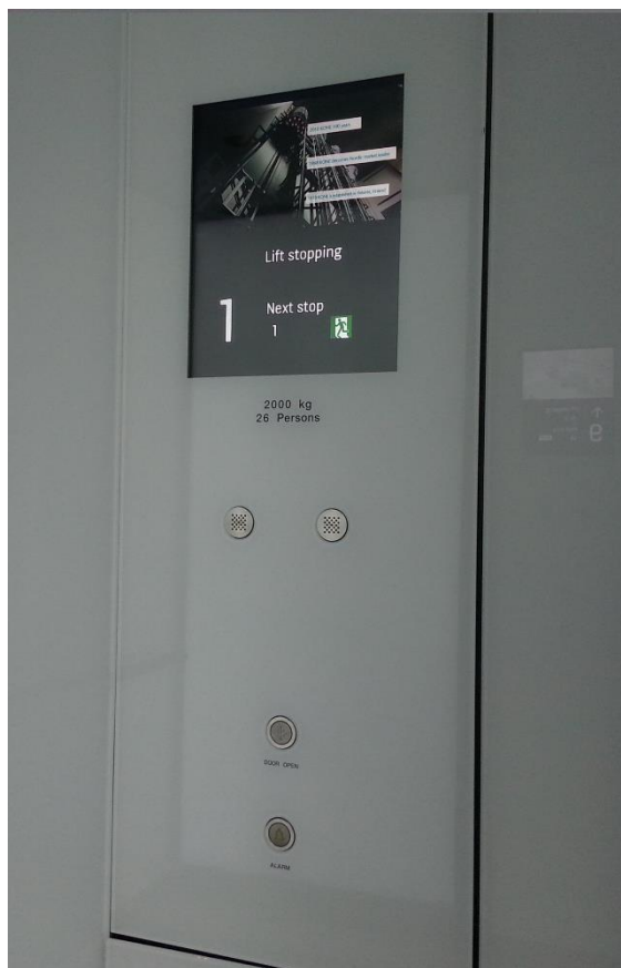
Kuva 5. Näytöllä varustettu hissikorinohjauspaneeli, COP.
