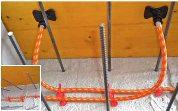
KUVIO 21. Injektointiletkuasennettu käyttämällä syöttökartioita (Intec-premium-asennusohje 2012, 12.)
