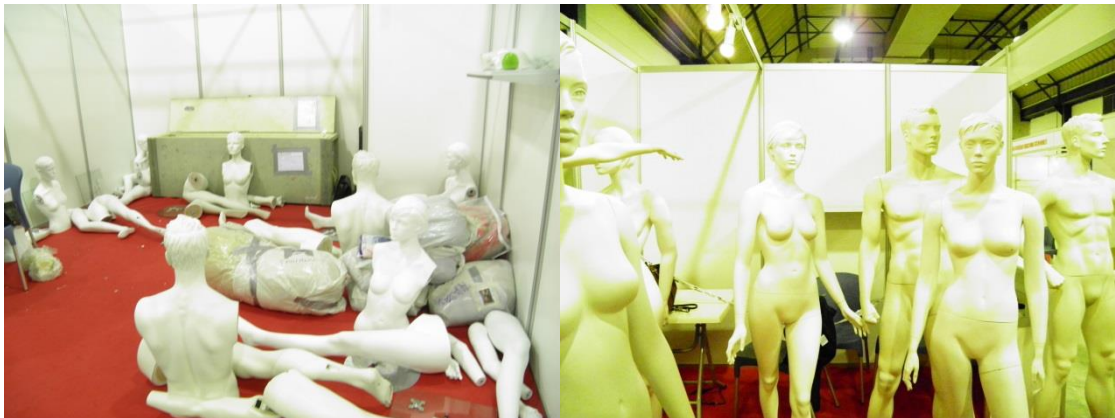
KUVIO 5. Messuosaston rakentamisen alkuvaiheet.
