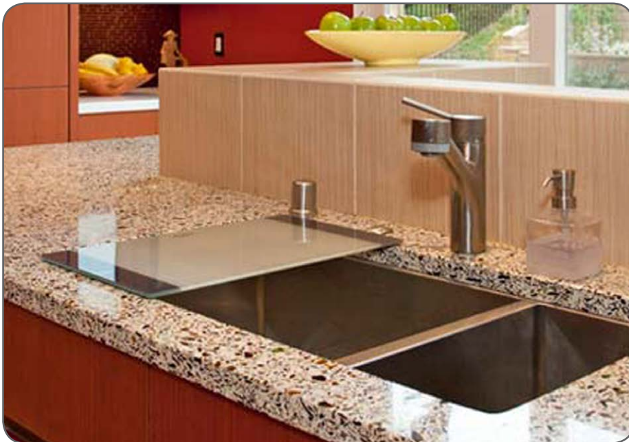
Kuva 2. Keittiön työtasojen koostumus on noin 80 % -90 % kierrätyslasia ja loput sidosaineta. (Vetrazzo n.d.)
