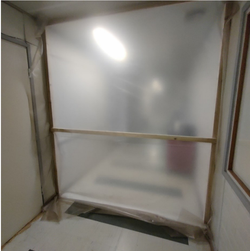
Kuva 3. Kahdentoista metrin keinosavua pidättävä tiivis päätyseinä
