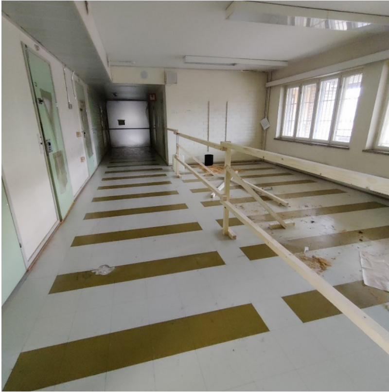
Kuva 6. Tilan rajaamiseen rakennettuja käytävän suuntaisia kaidarakenteita
