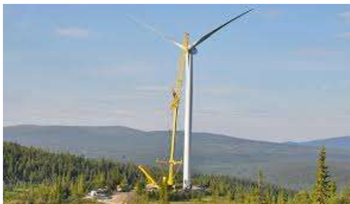
Figur 22. Installering av vindkraftverk. [42]
