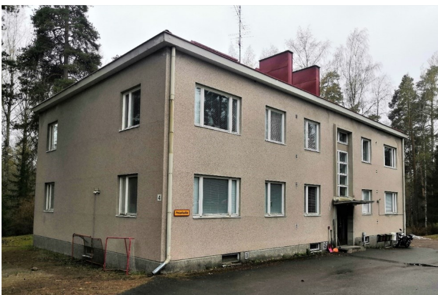
Kuva 7. Opettajien asuntolaksi alun perin rakennettu pienkerrostalarakennus
