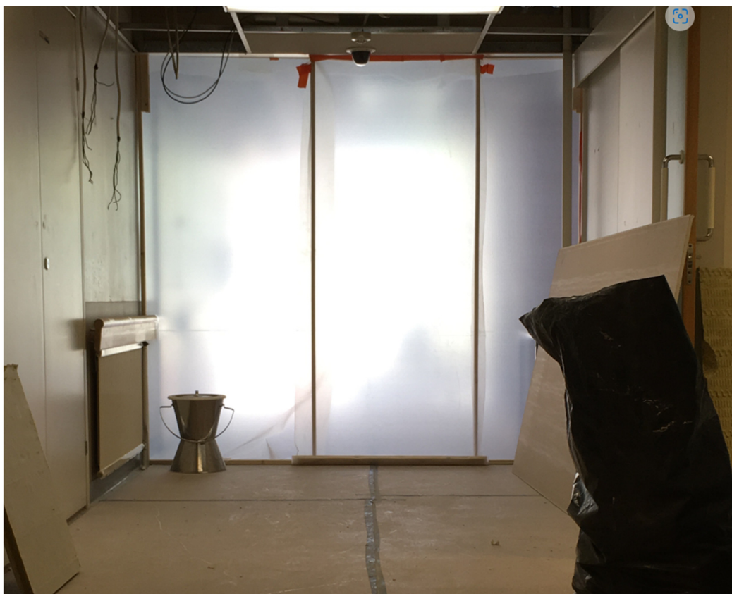
Kuva 5 P1 osastointi työmaalla
