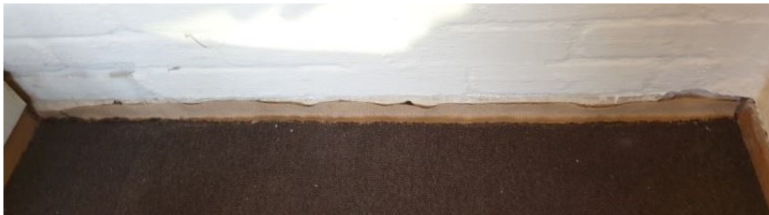
Kuva 31 Matto kiristettynä seinän viereen ennen jalkalistan kiinnittämistä (Kajaluoto 2022)
