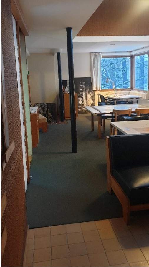
Kuva 8 Ateljeetilan länsiseinällä sijaitsee korjattava alue. (Kajaluoto 2022)
