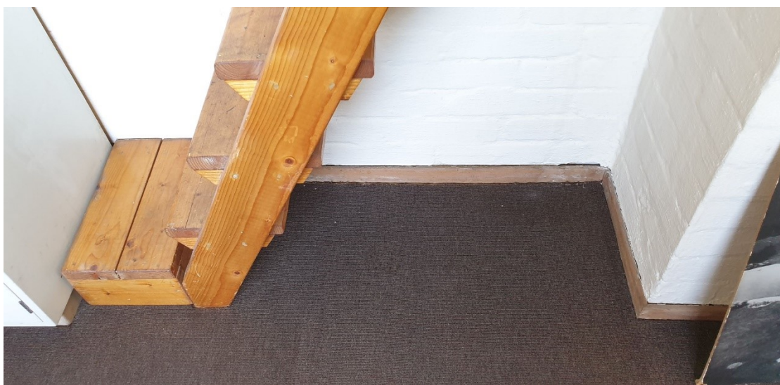
Kuva 32 Korjattu kokolattiamatto (Kajaluoto 2022)
