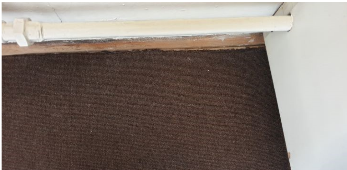
Kuva 36 Valmis korjaus ikkunan puolelta kuvattuna (Kajaluoto 2022)
