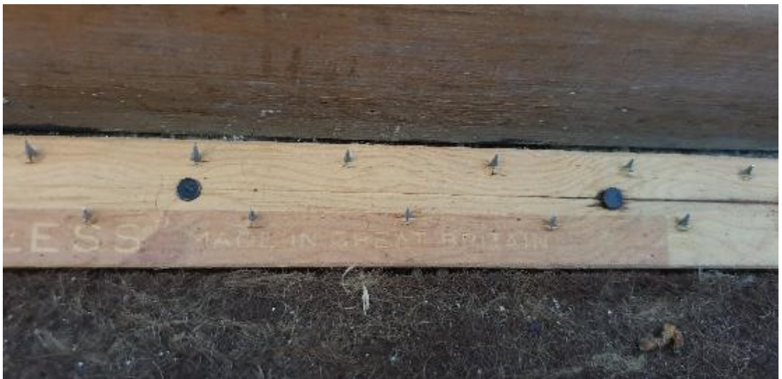
Kuva 26 Kokolattiamaton kiristyslista ja yläpuolella lattialistaa (Kajaluoto 2022)
