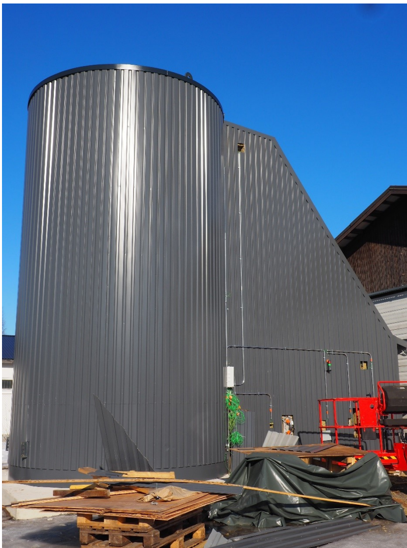
Kuva 10 Hiekkalämpövarasto rakennusvaiheessa 17.3. 2022 Kuva: Eino Hurttila
