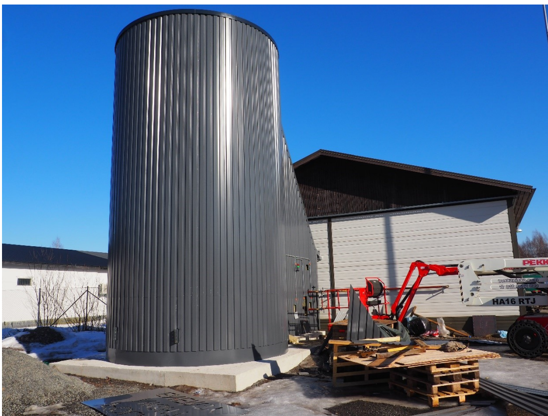
Kuva 1 Hiekkalämpövarasto sähkötöiden ollessa vielä kesken 17.3.2022 Kuvaaja: Eino Hurttila
