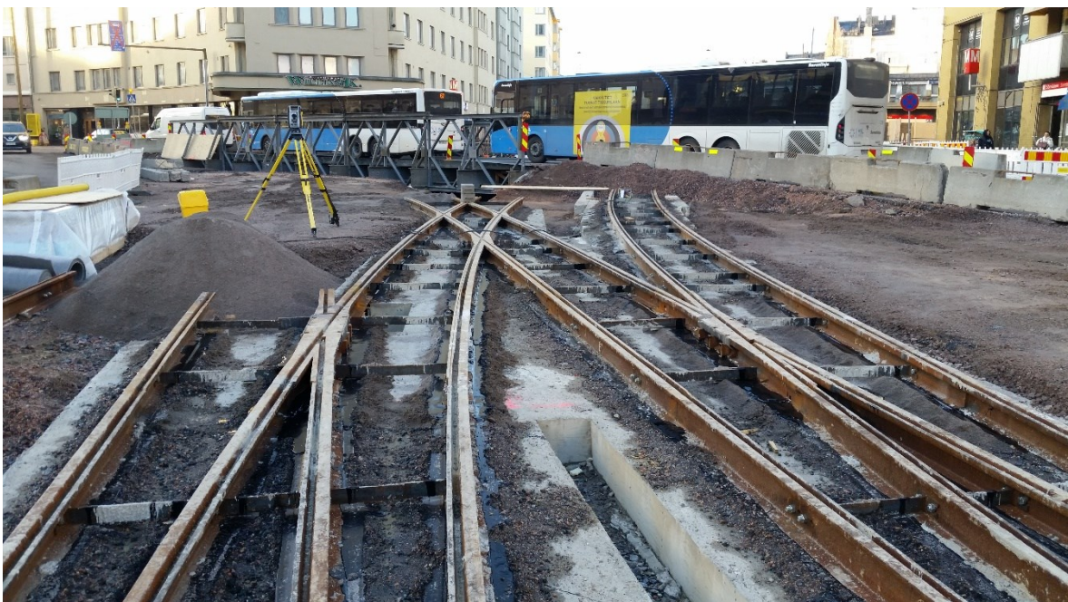
Kuva 2. Rakenteilla oleva kiintoraiderakenne Helsingin Sörnäisissä vuonna 2019
