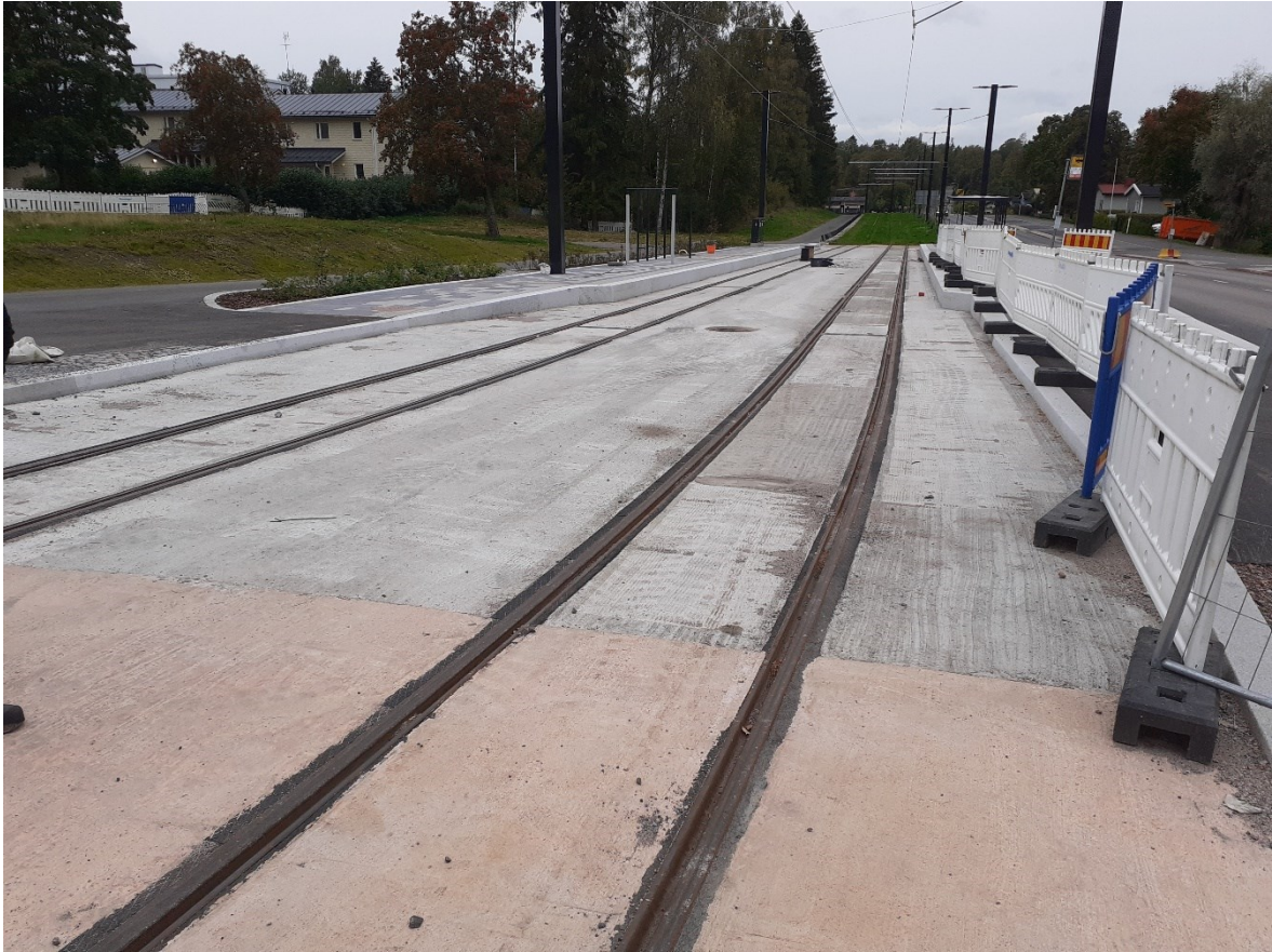
Kuva 8. Betonipäällyste Raide-Jokerin rakenteilla olevalla pysäkillä Pirkkolassa
