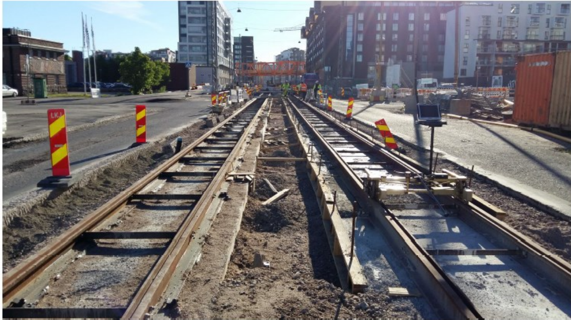
Kuva 7. Valumuottien käyttöä Helsingin Jätkäsaassa Välimerenkadulla (Kaupunkiliikenne Oy 2018)
