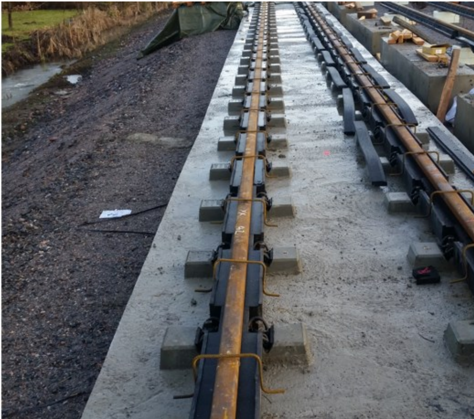
Kuva 6. Raide-Jokerin Ravitiellä pohjalaattaan kiinni valetut betoniset ratapölkkyt
