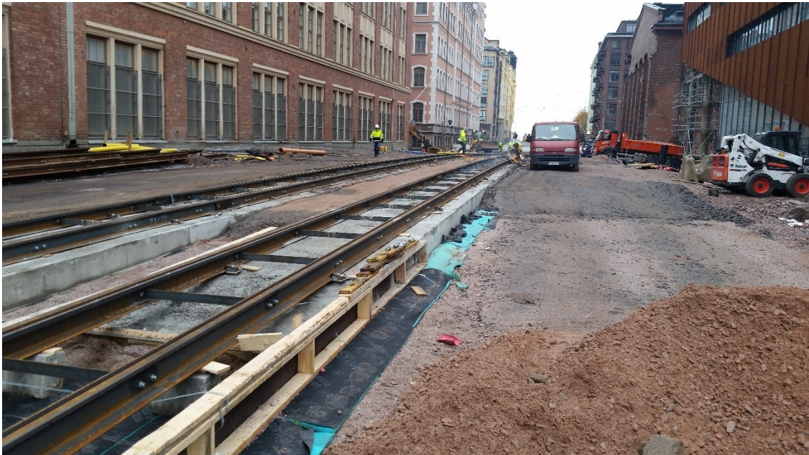
Kuva 1. Uuden raitiotieyhteyden rakentamista Telakkakadulla Helsingin Punavuoressa. Radan vasemmalla puolella vanhaa rakennuskantaa ja oikealla juuri valmistumassa oleva Euroopan kemikaaliviraston pääkonttori.
