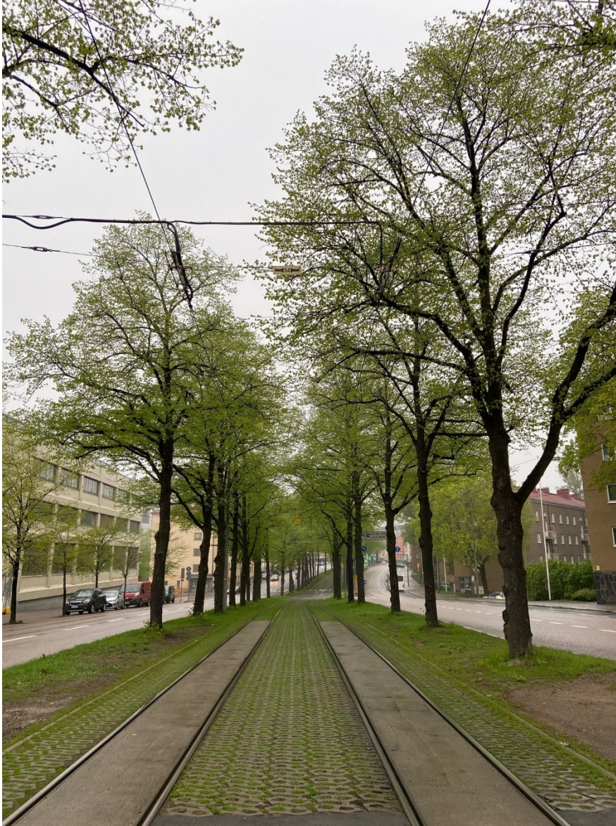
Kuva 4. Betonisella nurmikiveyksellä päällystetty rata-alue Helsingin Mäkelänkadulla
