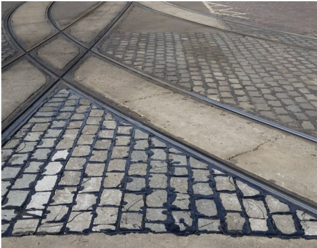
Kuva 3. Bitumisaumattu nupukiveys Helsingin Mannerheimintieellä
