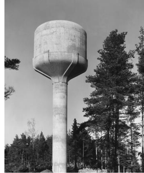
Kuva 2. Loviisan vesitorni, Heikki ja Kaija Siren, 1961. Kuva: Pietinen
