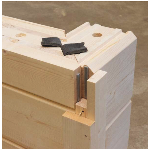
Kuva 4. Tiivistetty jiirinurkkaliitos
