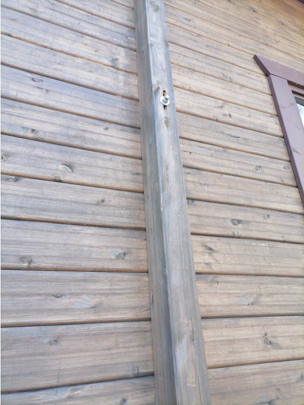
Kuva 22. Hirsiseinään asennettu följäri (Finn-Bois MTR 2022)
