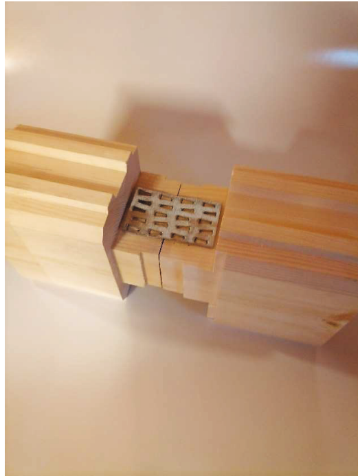
Kuva 8. Hirren jatkosliitos salvoksessa ilman eristettä
