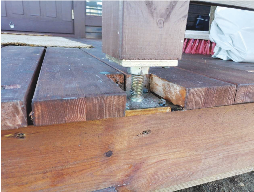
Kuva 23. Terassipilarin alapäähän asennettu säätöjalka (Finn-Bois MTR 2022)
