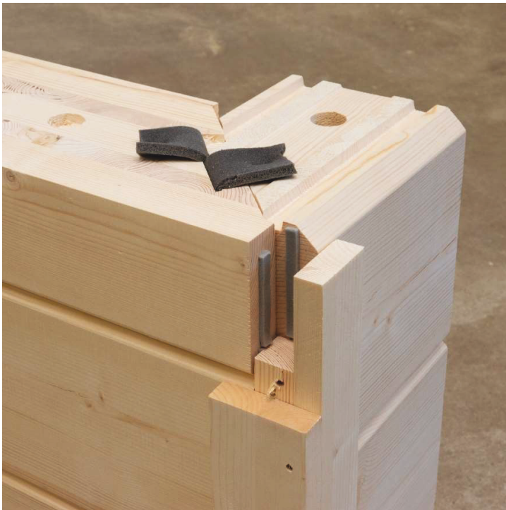
Kuva 20. Tiivistetty jiirinurkka (Finn-Bois MTR Oy 2022)
