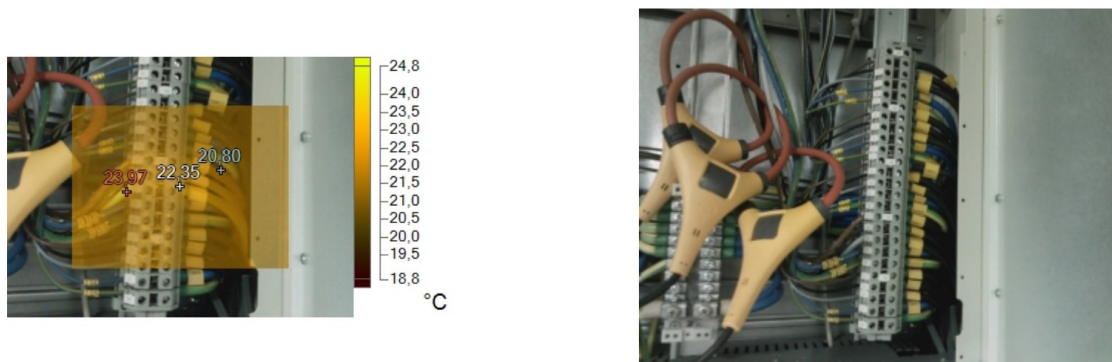
Kuva 14. Lämpö- ja digikuvan asettelu.
