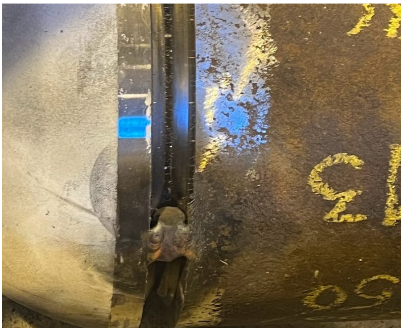
Kuva 4. Putken ja kuperan päädyn välinen hitsausseama, jossa apupala käytössä ilmaraon säilyttämiseksi.
