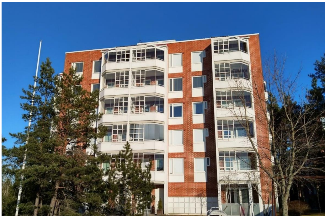
Kuva 7. Suunnittelukohteen rakennuksen julkisivu. (Uusitupa 2022)
