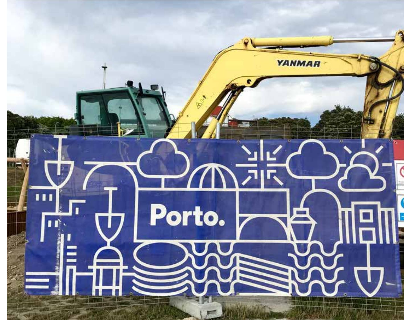
Kuva 38. Porton ilme työmaa-aidassa (Shevchenko 2019)
