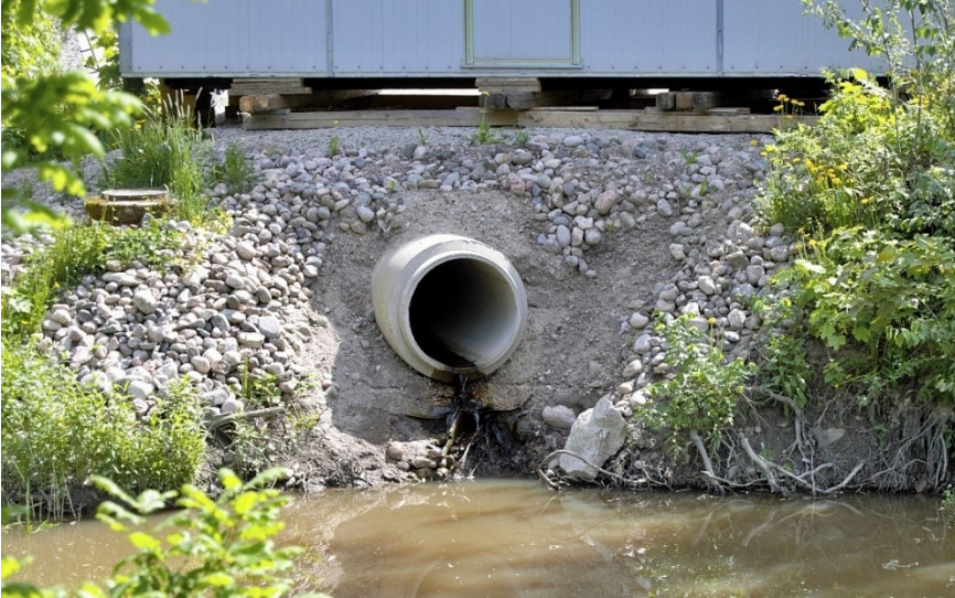
Kuva 15. Kuva Orimattilan keskustasta Palojokeen johdetusta hulevesiputkesta. (Ahonen, 2021)
