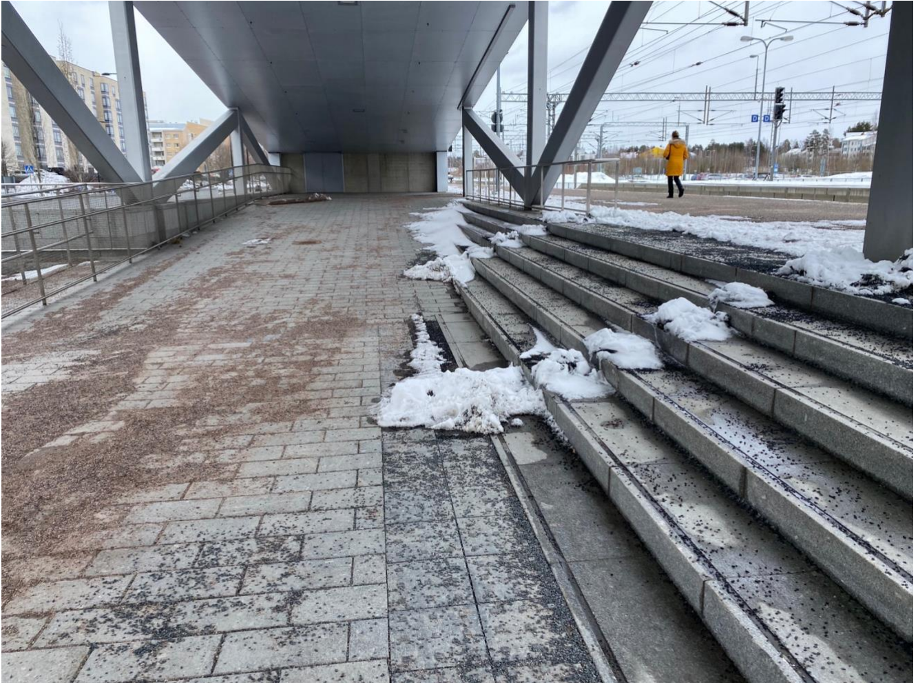
Kuva 1. Tikkurilan bussiterminaalin portaikko ja ramppi 6.4.2022
