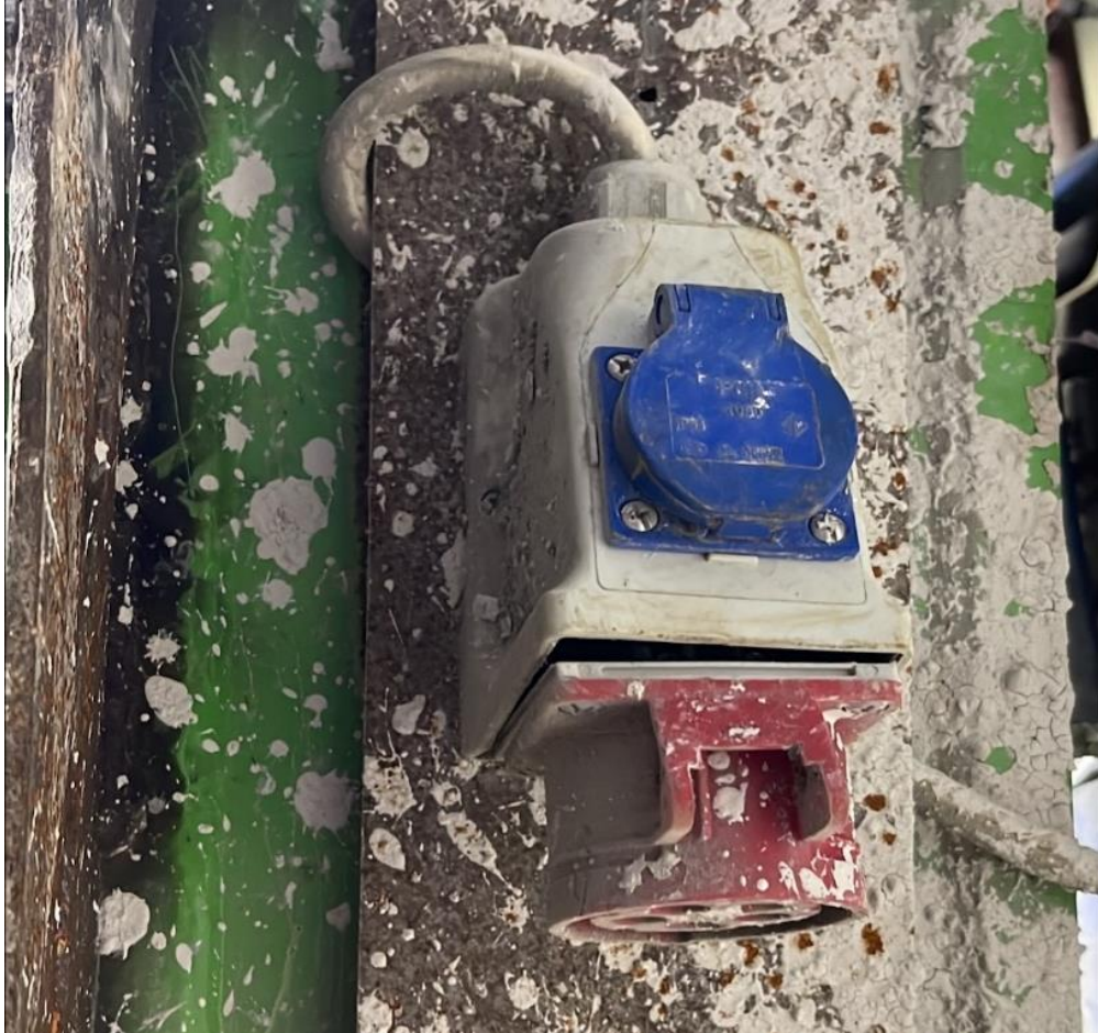
Kuva 13. Rikkinäinen voimavirtapistorasia.
