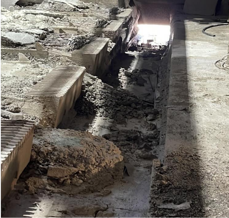
Kuva 11. Suojaamaton jätteiden keräysmonttu.
