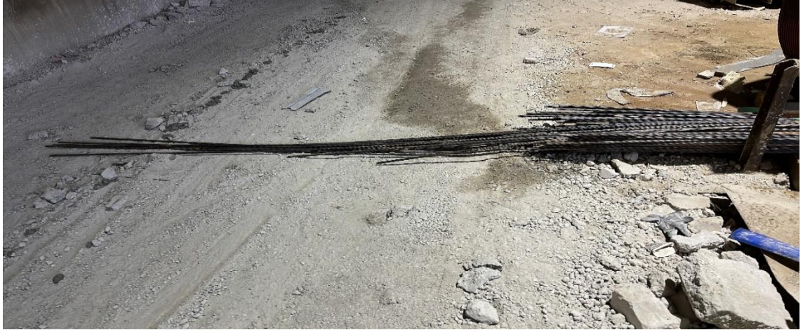
Kuva 9. Teräspunoksia kulkukäytävällä.
