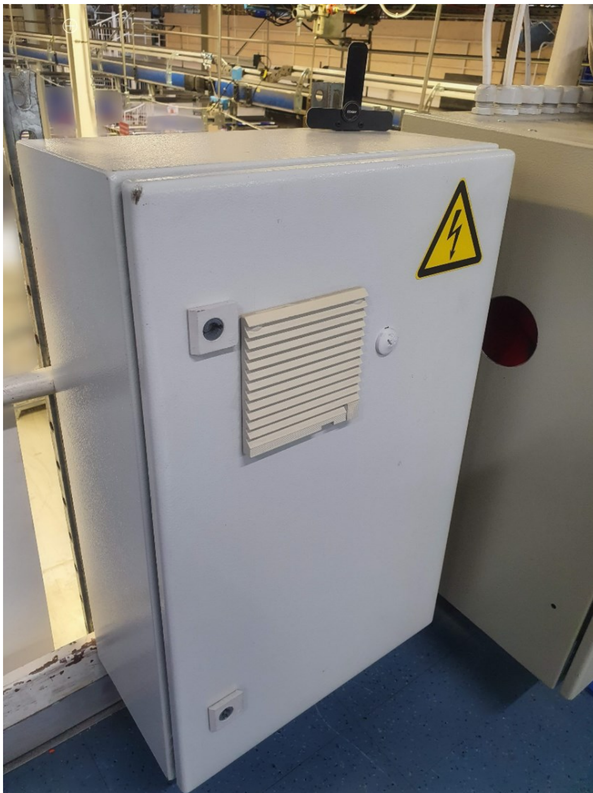
Kuva 15. Sähkökaappi asennettuna, taustalla näkyy kohdeihnakuljetin.
