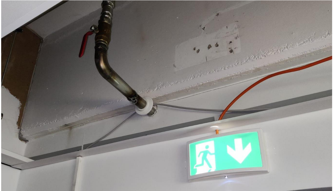
Kuva 26 Vuoto runkolinjassa. Lopullinen havainnointi tehtiin saippuveden avulla.
