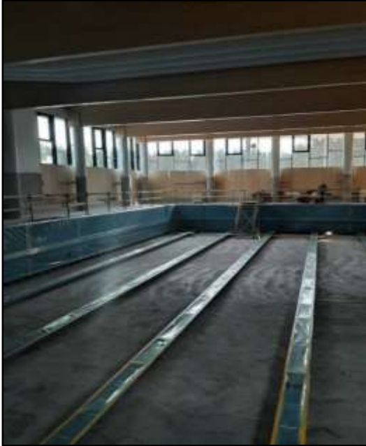
Kuva 19. Seinäelementit ja pohjakanaalit asennettu. (Mannonen, 2021)
