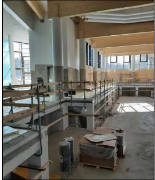
Kuva 18. Jaloteräsallaspaikan ulkopuoliset rakenteet. (Mannonen, 2021)
