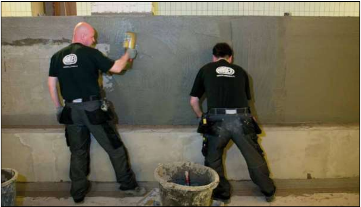
Kuva 14. Uima-altaan vedeneristys ja laatoituseseite. (Antikainen, 2022)
