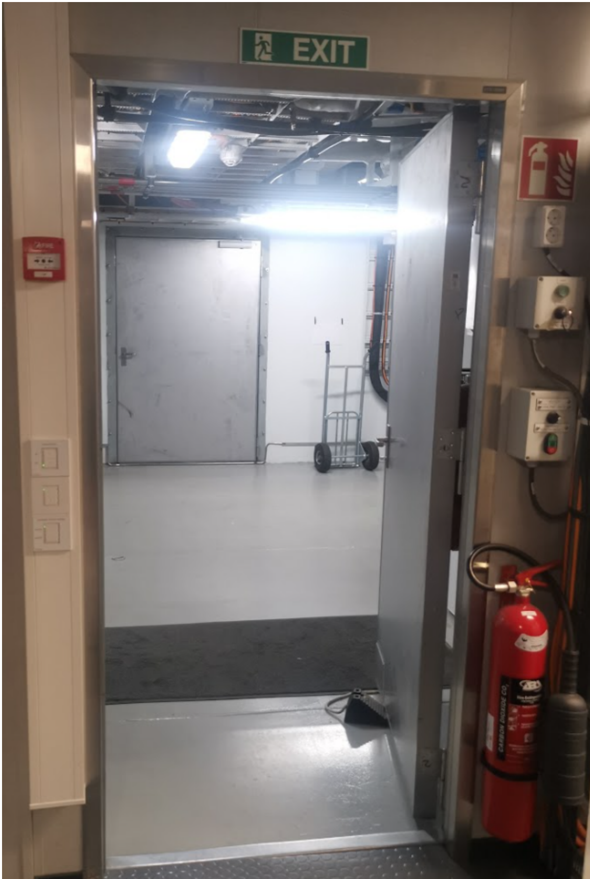
Bilaga.2 Ingång till kontrollrummet från styrbord sida.
