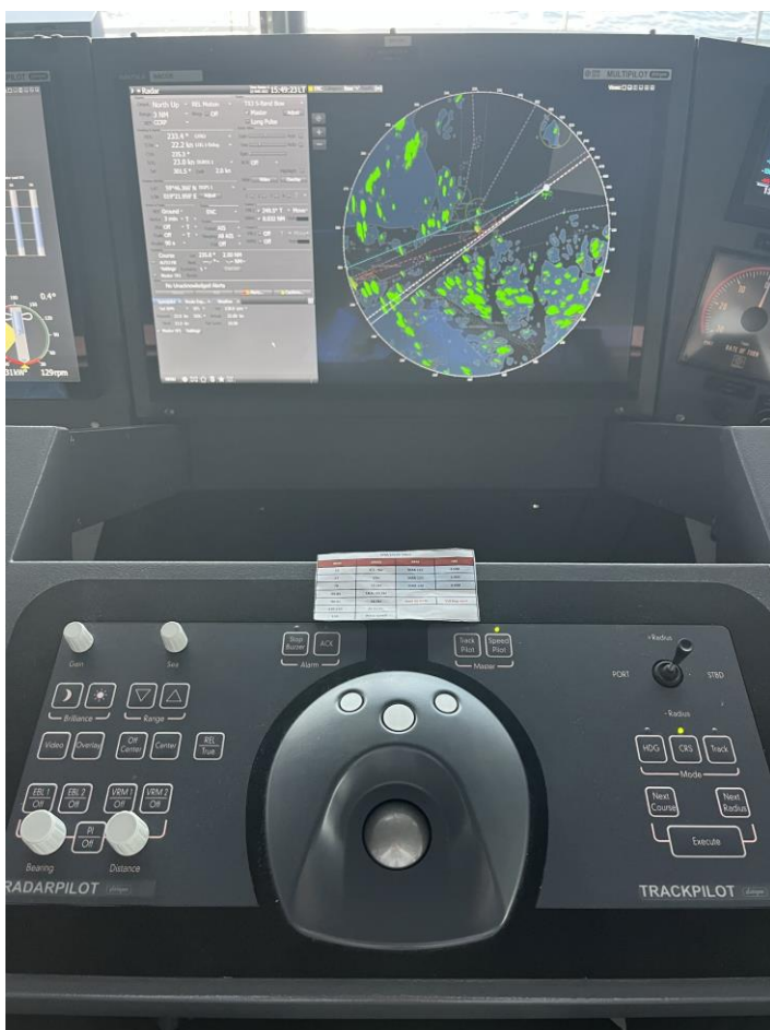
Kuva 5: Wärtsilä NACOS Platinum MFD ja Wärtsilä Trackpilot
