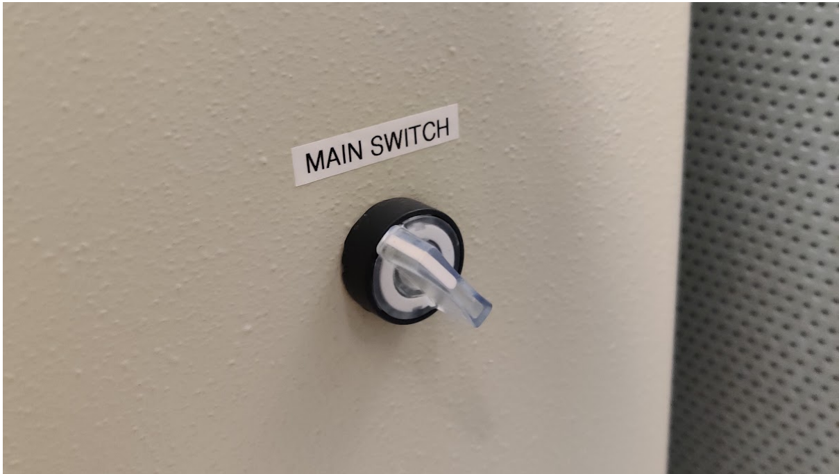
Figur 19. Huvudbrytaren på manöverskåpet.
