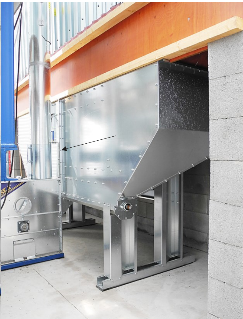
Kuva 2. Kaatoallas, sulkuluukun sijainti ja elevaattori (Araska-metalli, i.a.-a).
