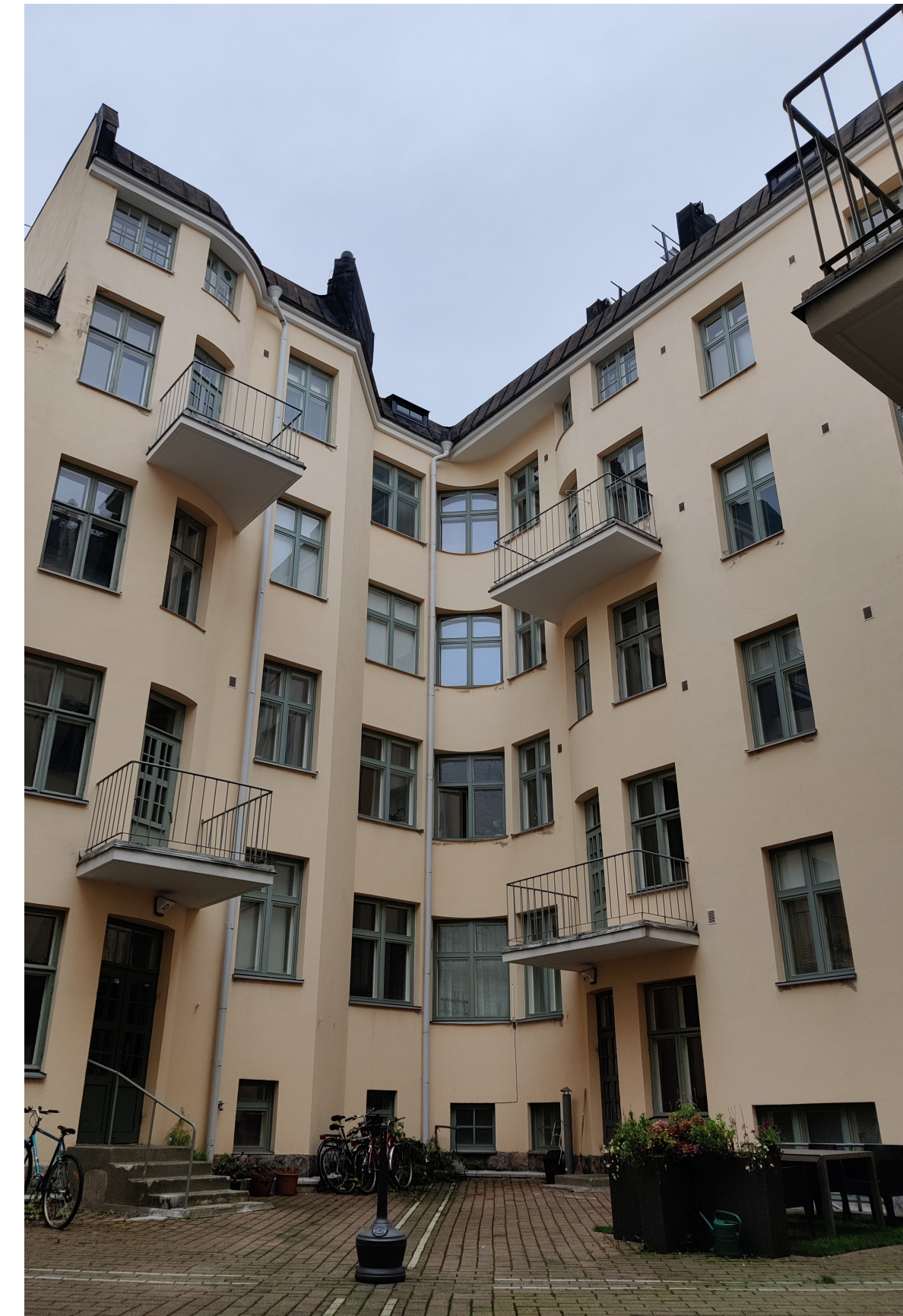
Kuva 17: Näkymä rakennuksen sisäpihalta
