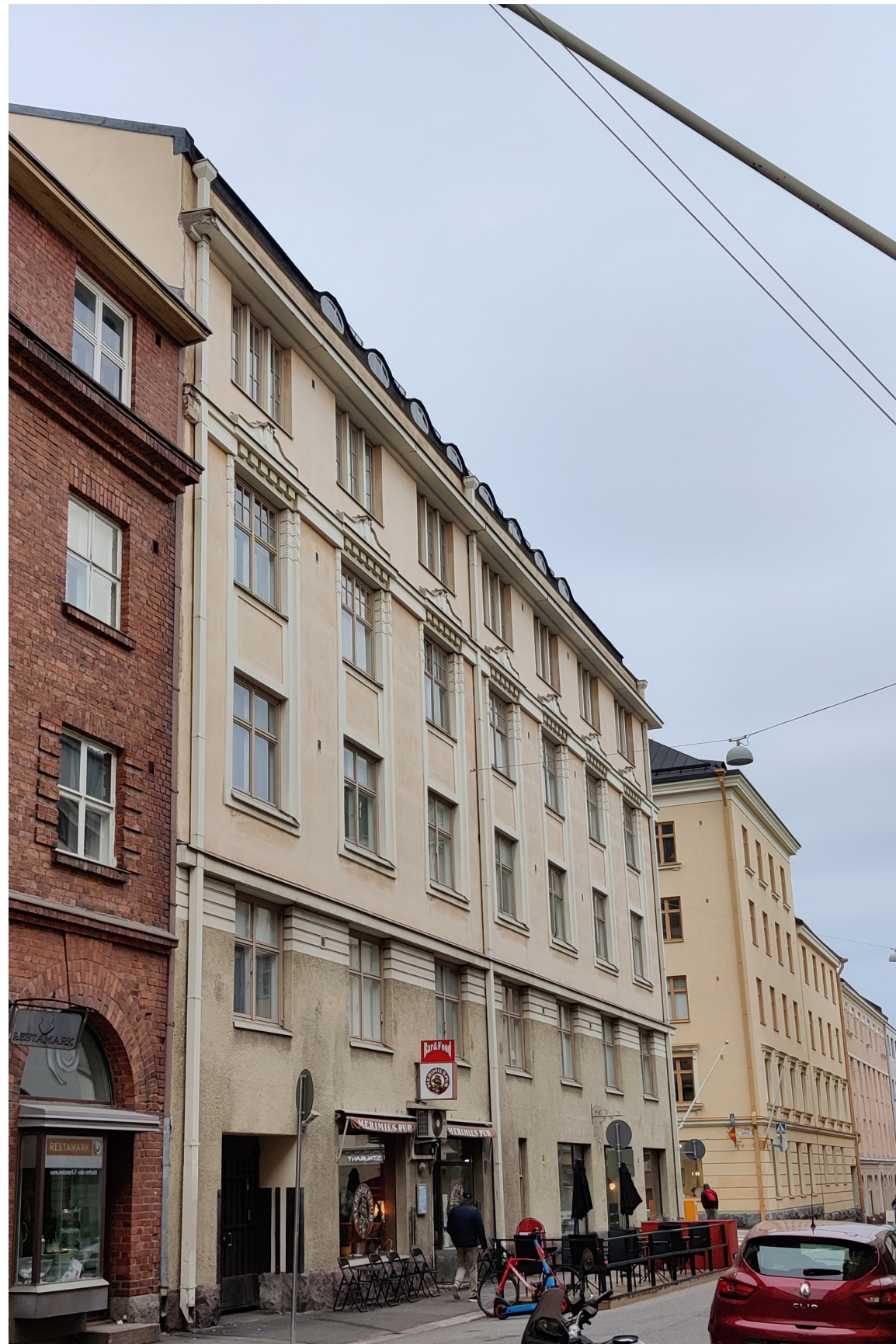
Kuva 15: Rakennus kuvattuna Merimiehenkadun puolelta
