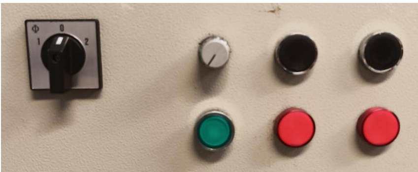
Kuva 3. Sähkökaapin ohjauskytkimet
