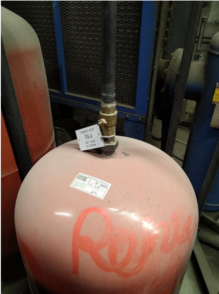
KUVA 16. Paisunta-astian huoltosulku suljetaan, paisunta-astia irrotetaan verkostosta ja tyhjenetään nesteestä esipaineen tarkastamiseksi.
