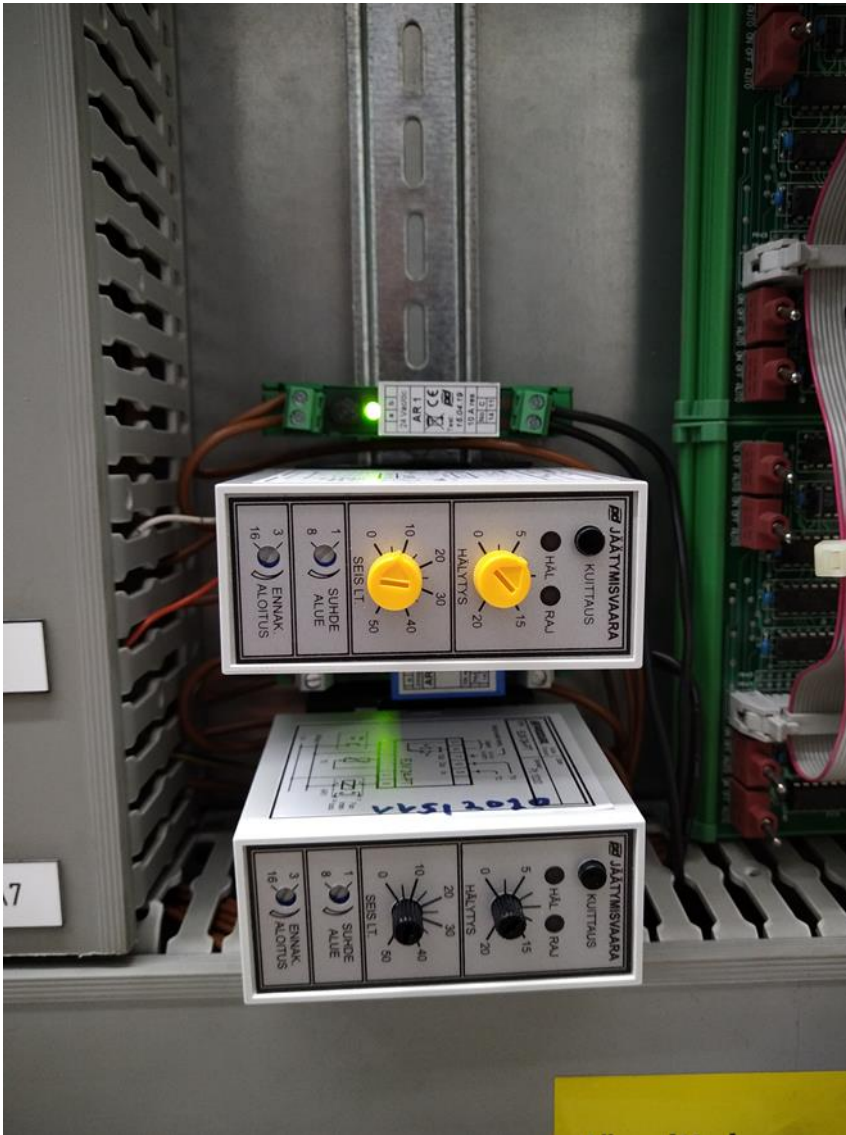
KUVA 8. Jäätymissuoja laukaistaan nostamalla hälytysarvoa potentiometrillä. (keltainen oikealla)
