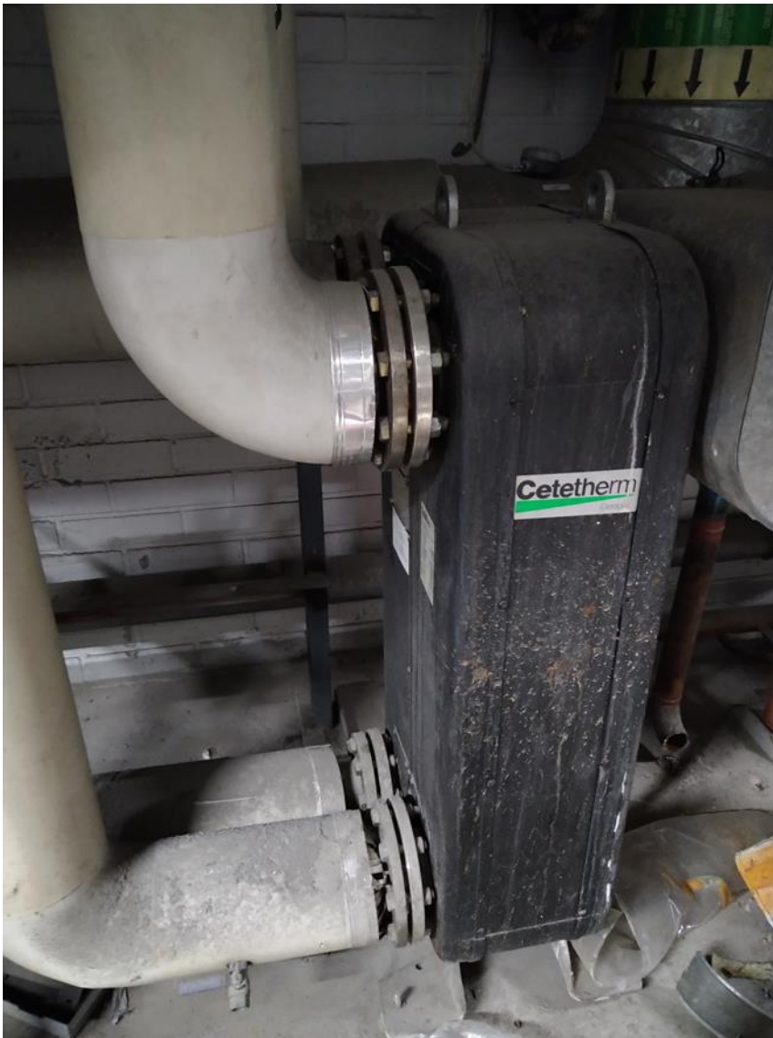
KUVA 13. Lämmönsiirrin tarkastetaan vuotojen varalta.
