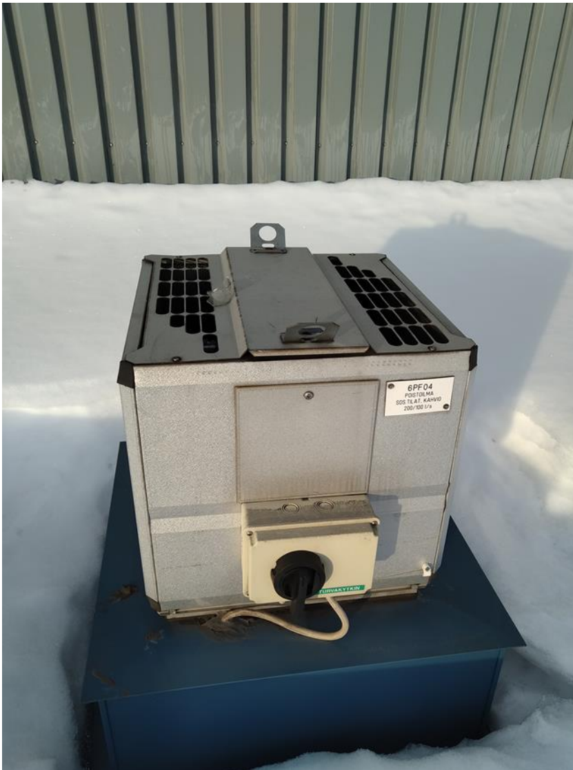
KUVA 10. Huippuimuri 6PF04 Liitintien katolla
