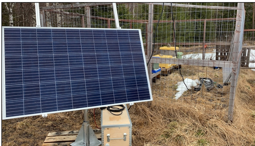
Kuvio 5. Lämmitys- ja seurantalaitteiston aurinkokennosto
