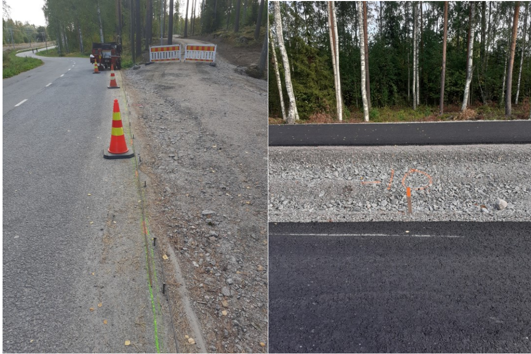
Kuva 20. Maastoon tehtyjä merkintöjä valettavaa reunakiveä ja asfaltointia varten
