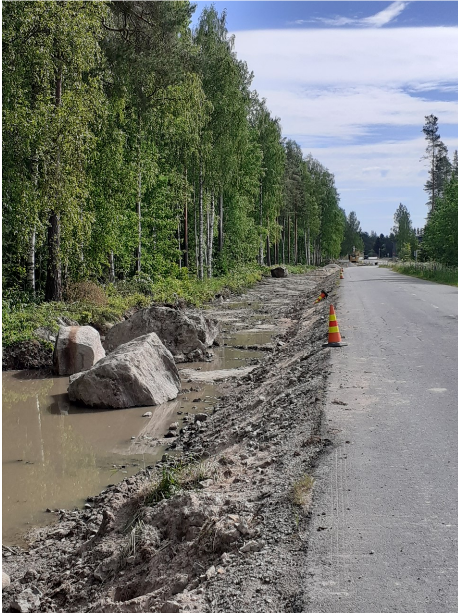
Kevyen liikenteen väylän pohja kaivettu perusmaalle
