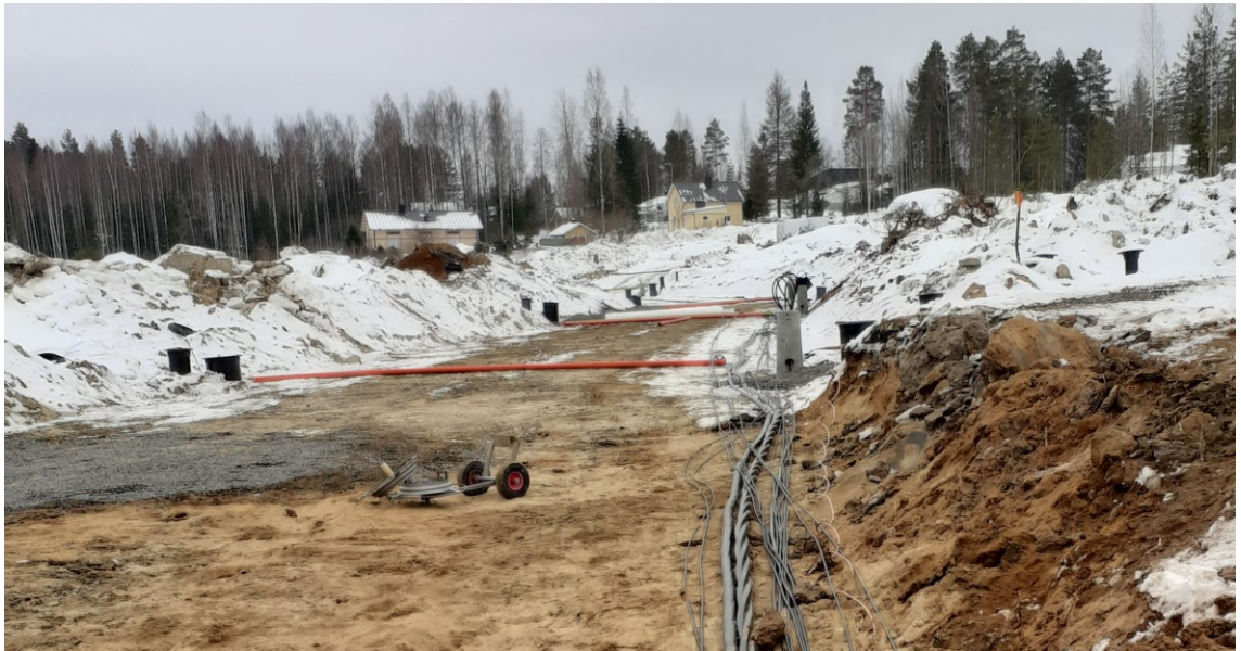
Kuva 9. Kaapelointivaihe kadun rakentamisessa
