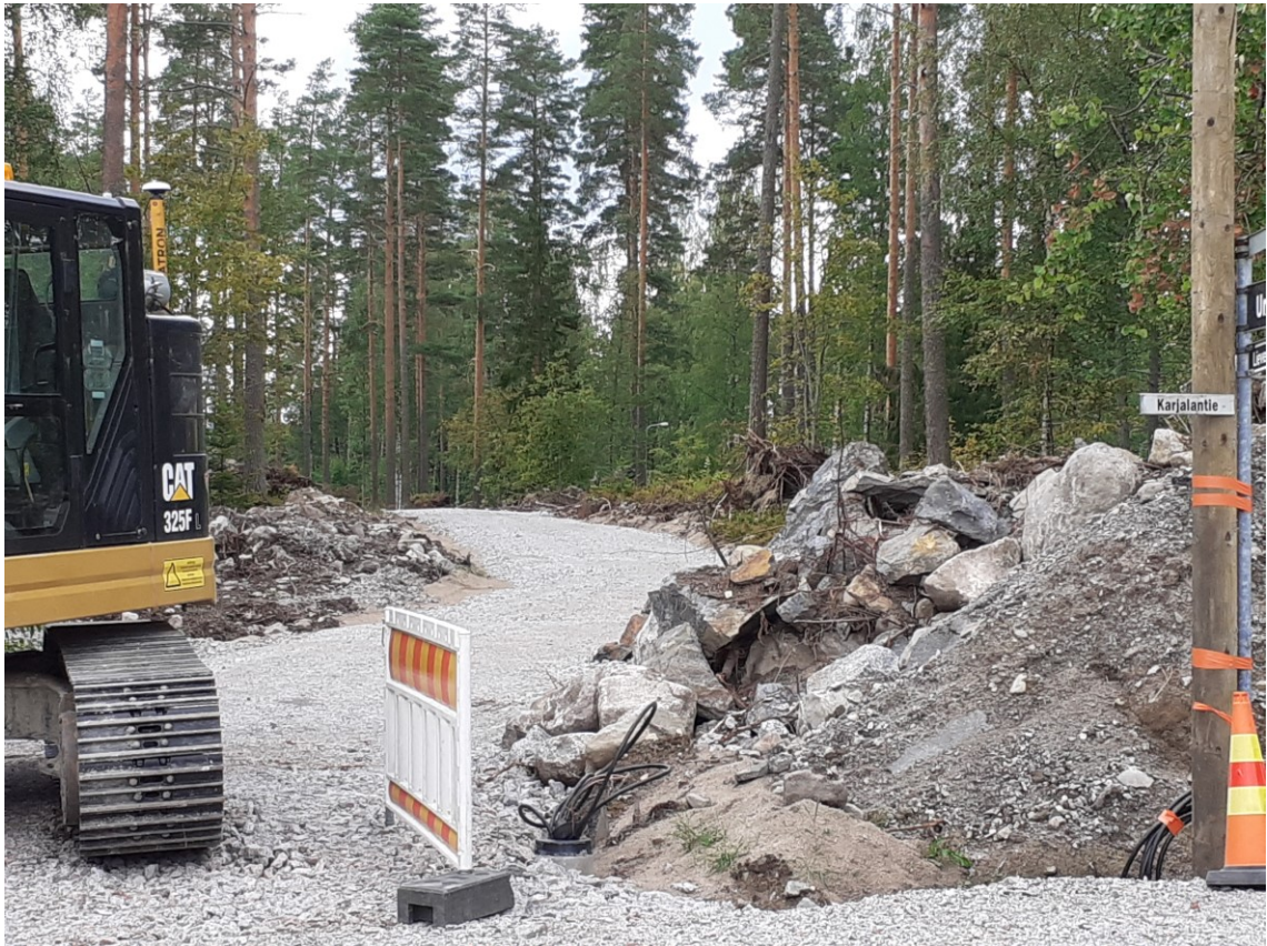
Kuva Ratatien, Karjalantien ja kevyen liikenteen väylän risteyksestä
