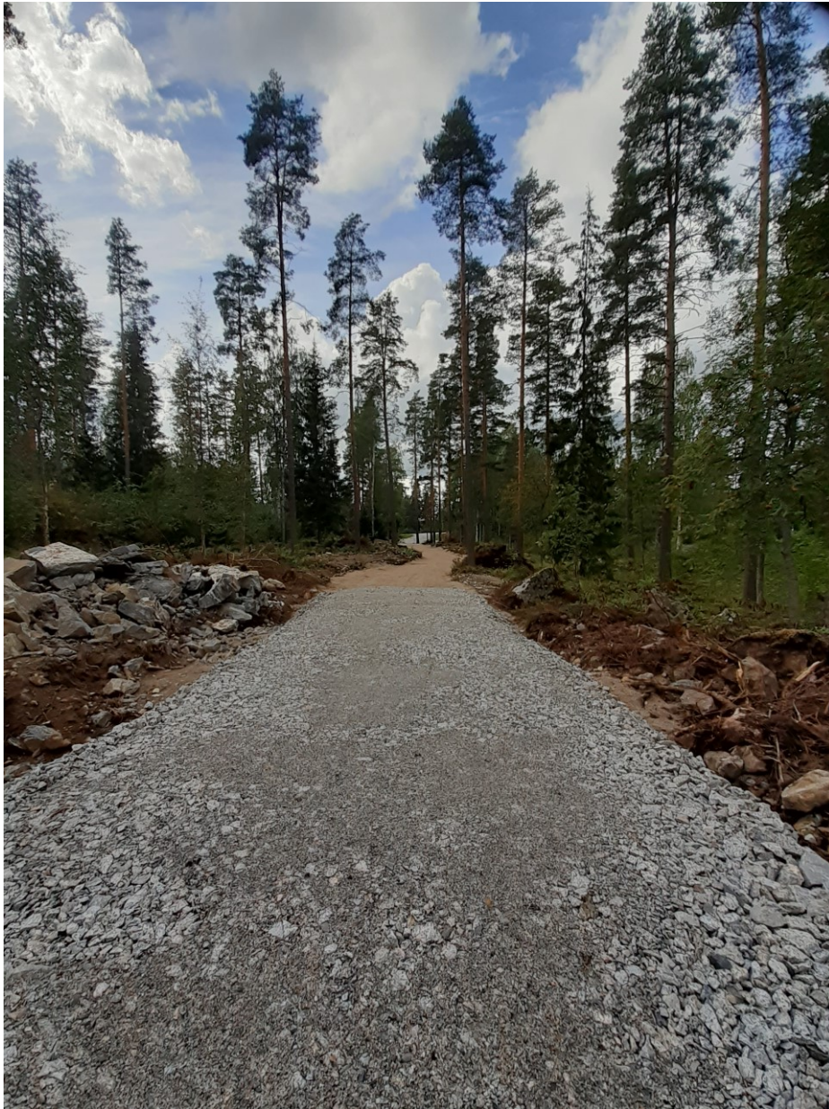
Keuyen liikenteen väylän kerroksia
