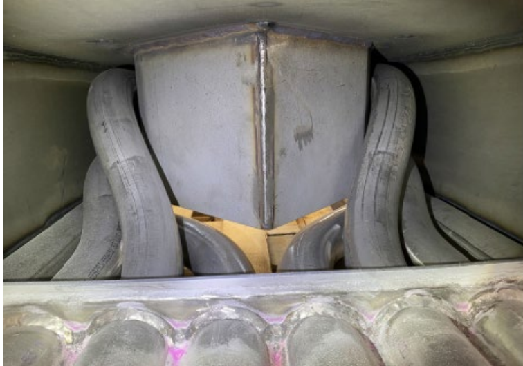
Kuva 4. Ilma-aukon massakotelo sisältä katsottuna
