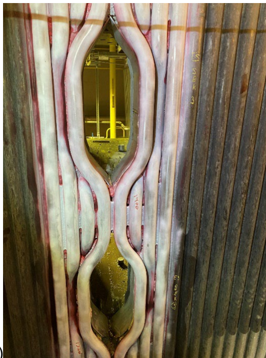
Kuva 7. Esimerkki a) sekundääriaukon ja b) tertiääriaukon rakenteesta
