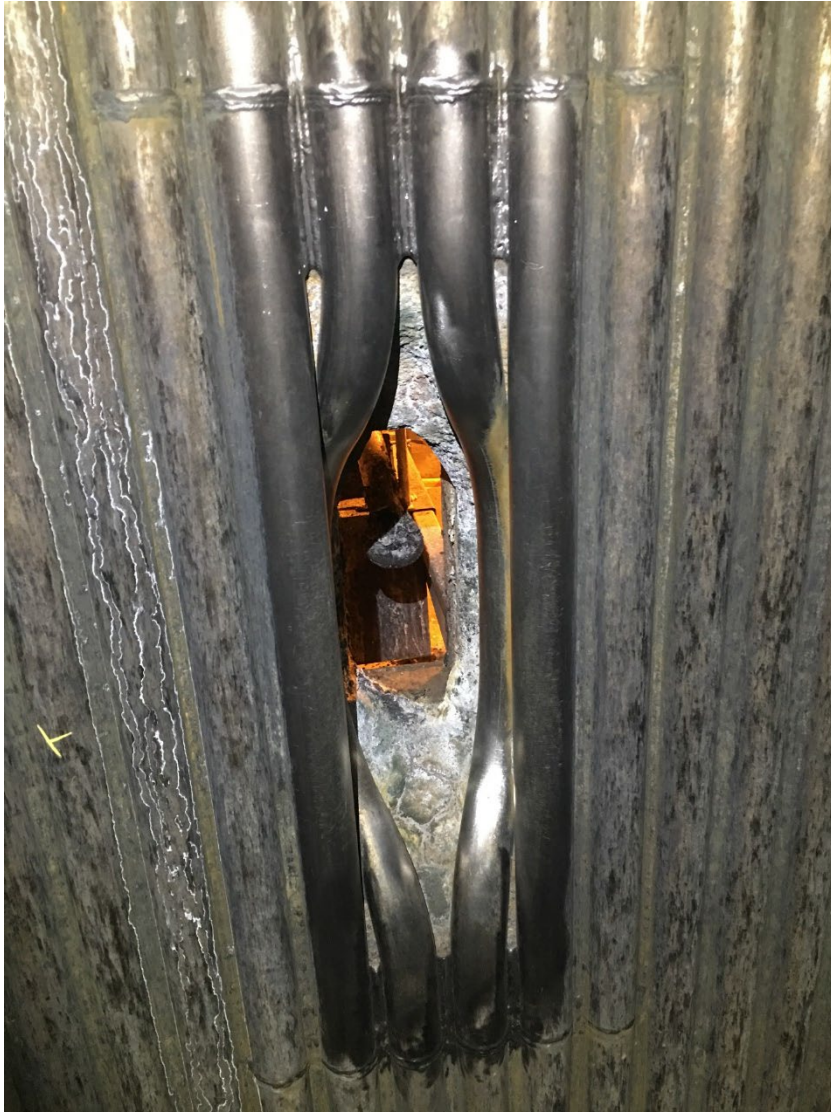
Kuva 9. Esimerkki lipeäruiskuaukon rakenteesta
