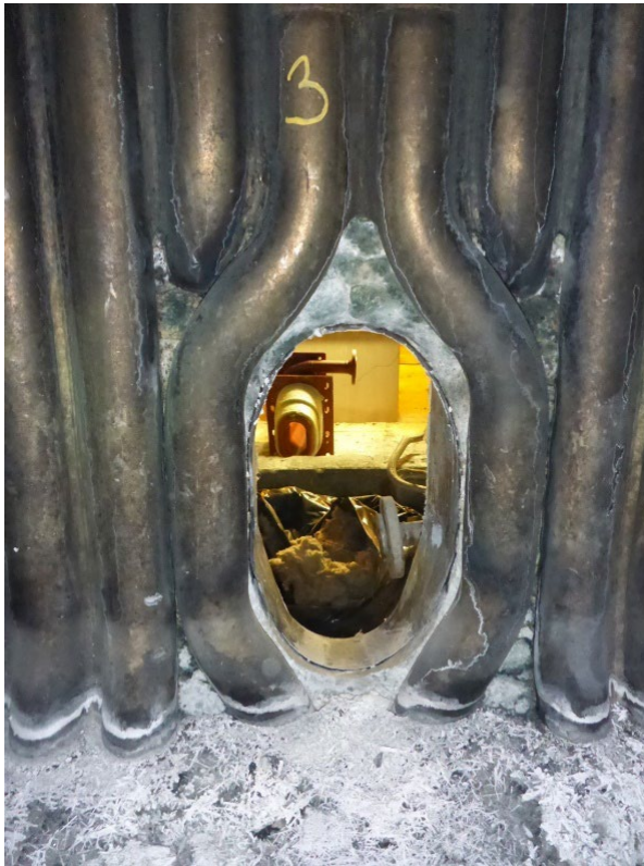
Kuva 5. Sula-aukon rakenne sulakouru poistettuna
