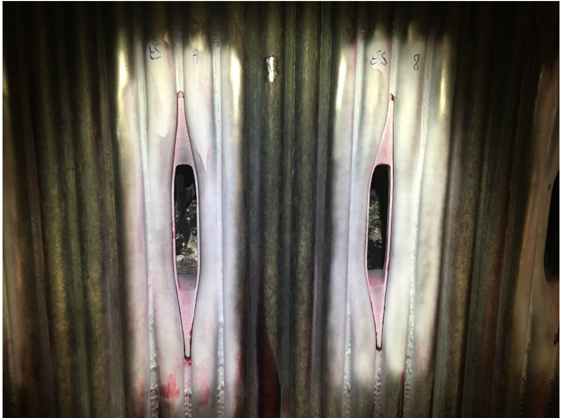
Kuva 6. Primääriaukkojen rakenne, valusuuttimilla varustettu primääriaukko
