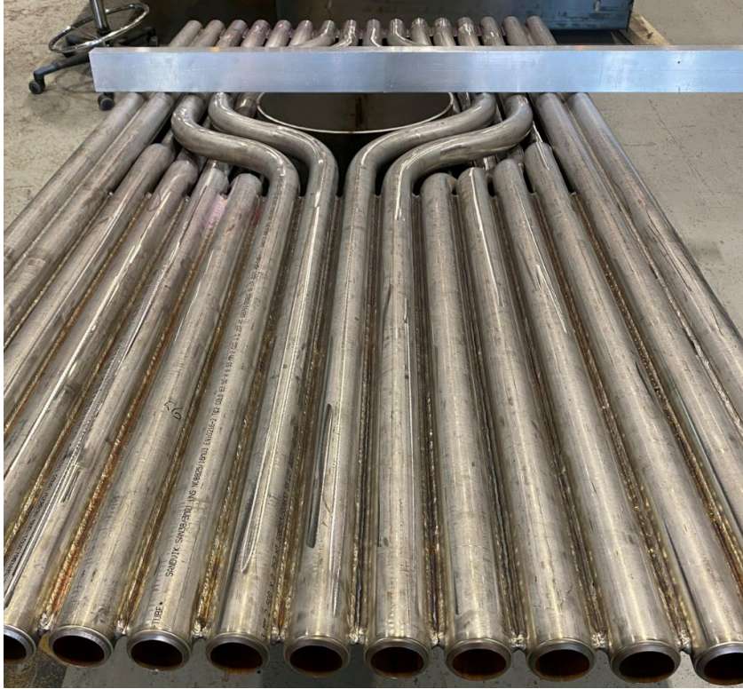
Kuva 28. Putkien linjauksen tarkastus oikolaudan avulla.
