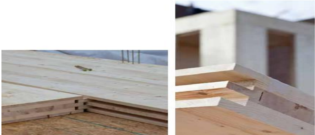
Kuva 26. Internal spline (Douglas 2013, 192)
