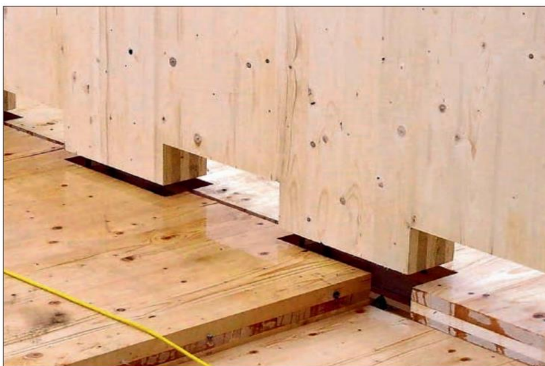
Kuva 20. Massiivipuulevyn kontaktiliitos (Lahtela 2021, 95)
