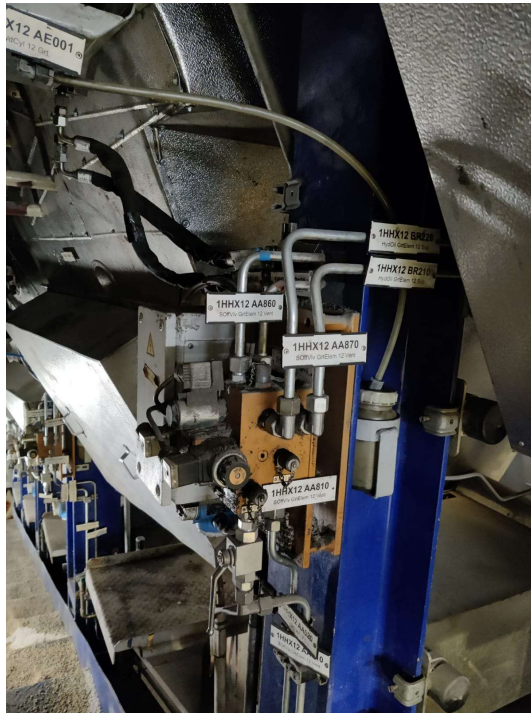
Kuva 3. Arinalohkon hydraulikkalohkon konekyllit.
