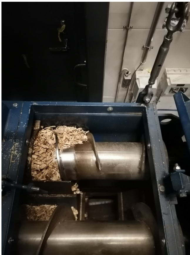
KUVA 17. Polttoaineen syöttöruuvi ja sulkusyötin (Luukkonen 2022)
