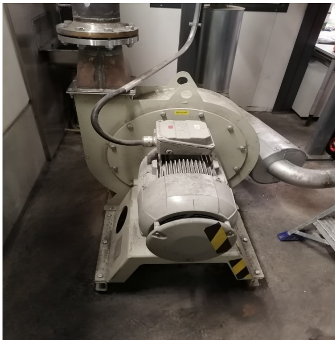
KUVA 14. Palamisilmapuhallin (Luukkonen 2022)
