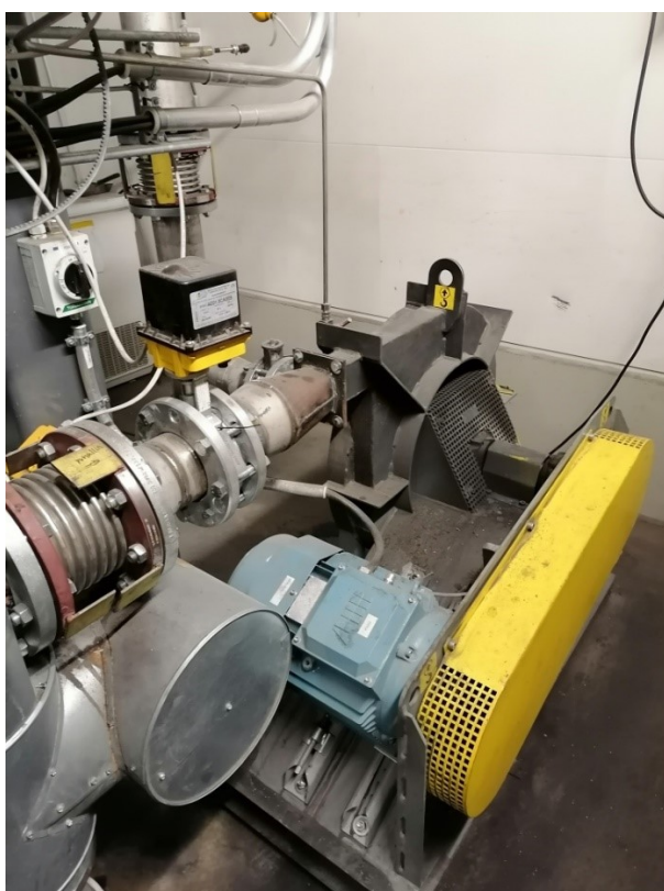
KUVA 15. Kiertokaasupuhallin (Luukkonen 2022)
