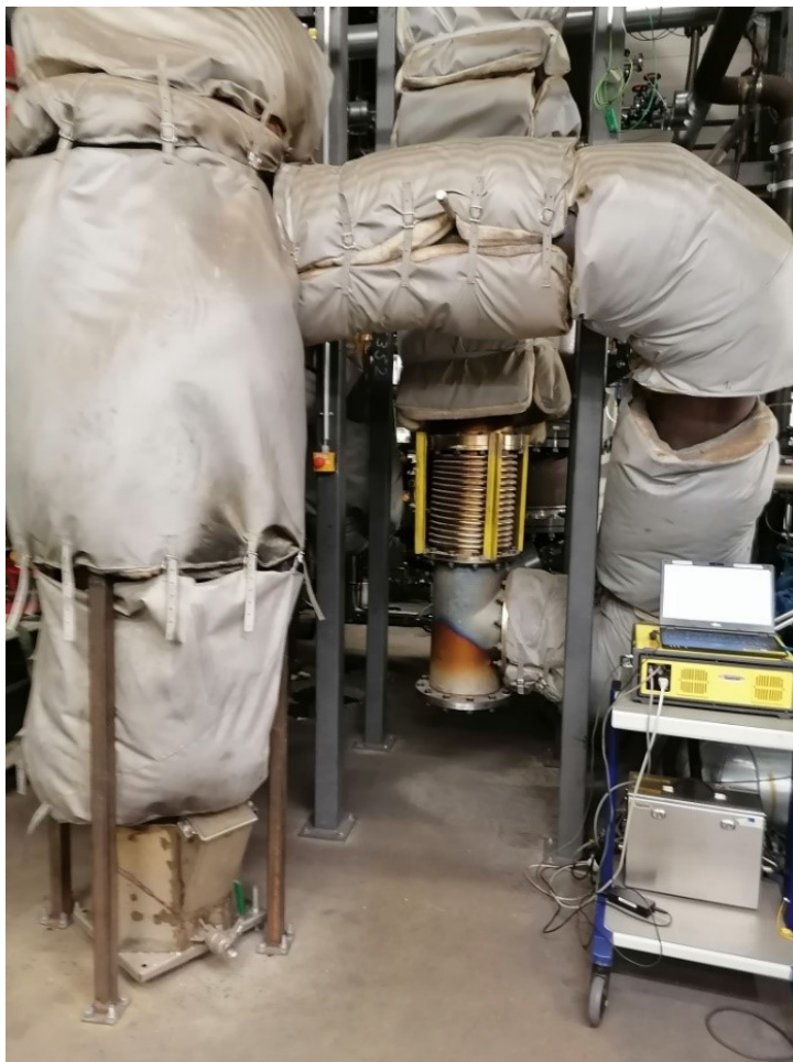
KUVA 18. Sykloni, takaveto ja FTIR savukaasuanalysaattori (Luukkonen 2022)
