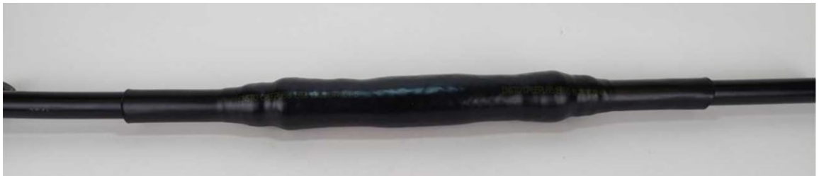
Kuva 19. Hybridijatkos asennettuna testikaapelille.
