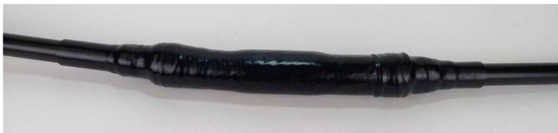
Kuva 12. Kylmäkutistejatkos asennettuna referenssikaapelille.
