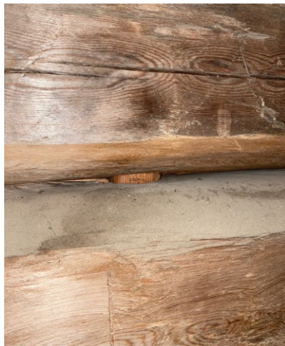
KUVA 7. Hirsirakennetta jäykistävä tapitus näkyvässä
