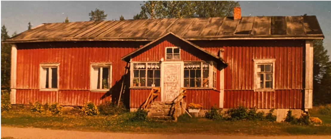
KUVA 16. Vuoden 1998 kuvassa vanhan puolen kuisti
