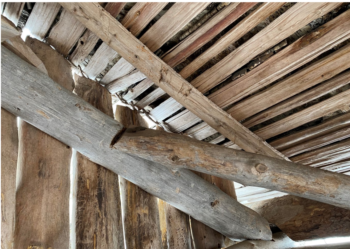
KUVA 18. Punutut alusmalat ladon sisäpuolella
