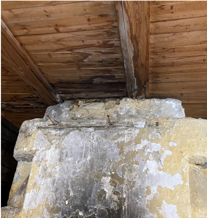
KUVA 20. Hormin vuotojälki
