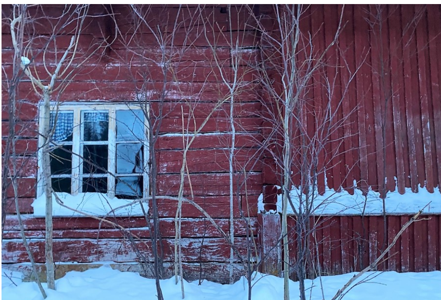
KUVA 15. Osittainen ulkoverhous pohjoispuolen seinällä
