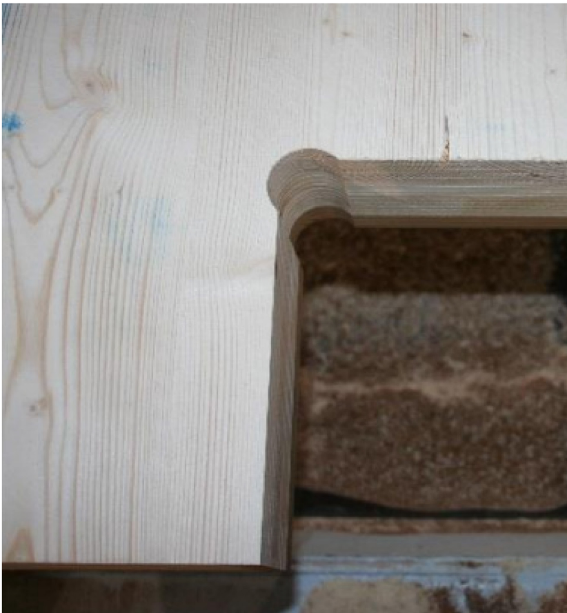
KUVA 12. Tappiijrsimellä tehty aukon kulma (9, s. 51)
