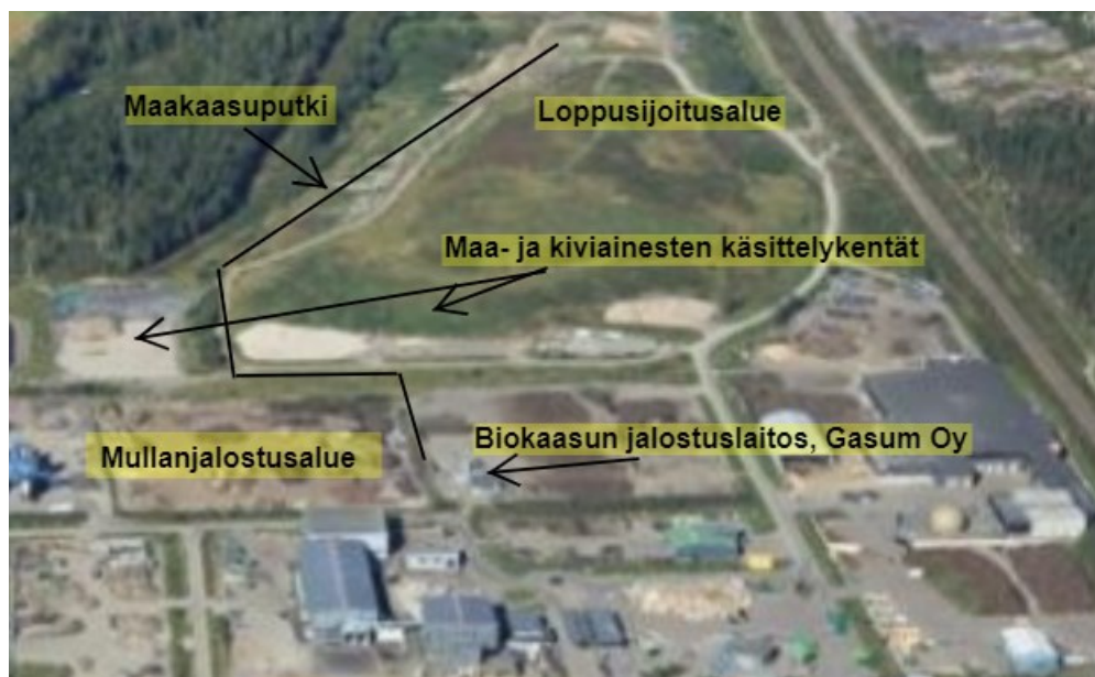
Kuva 4. Rakennettavan maakaasuputkiston ympäristö Kujalan käsittelykeskuksen alueella [13].
