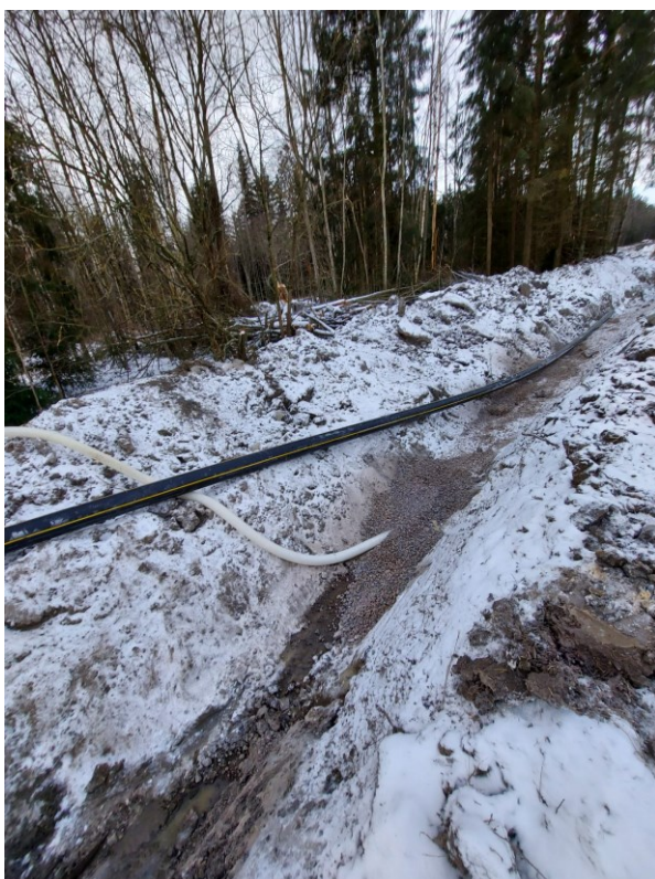
Kuva 17. Salaoja- ja maakaasuputki kaivannossa. Oma arkistokuva.
