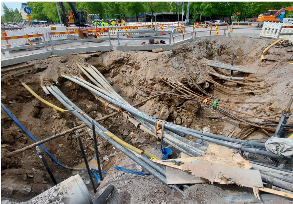
Kuva 8. Helsingin Kaarlenkadun katutyöt kesä 2021. Oma arkistokuva.
