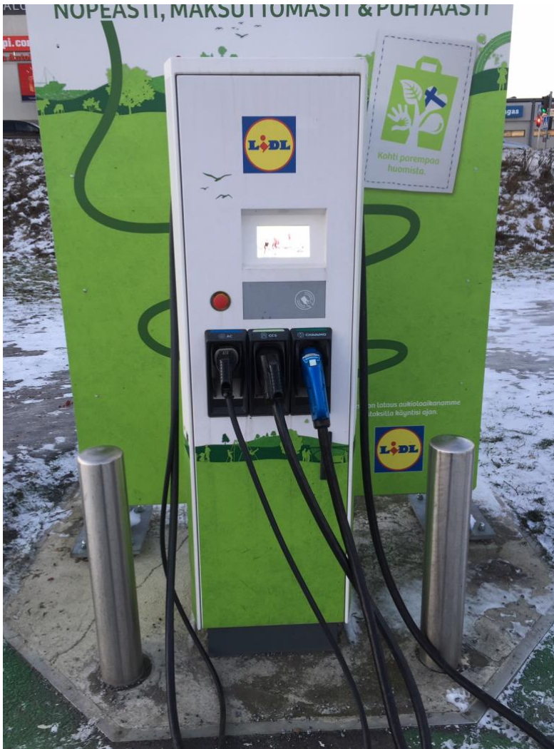
Kuva 6. Mode 4 DC - pikalatausasema. Latausasemassa Type 2-, CCS-, ja CHAdeMo-liittimet.
