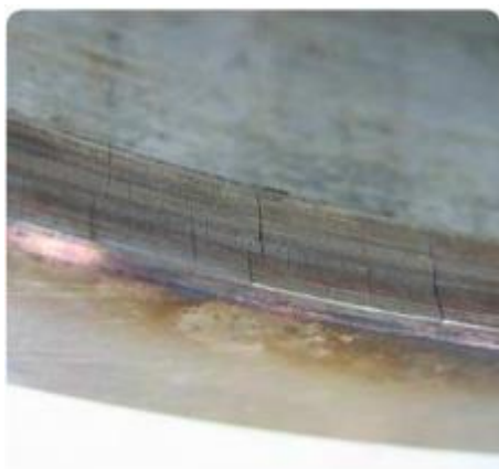
Kuva 20. Lämmöstä aiheutuneet halkeamat.
