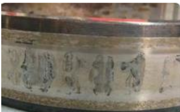
Kuva 9. Kosteudesta syntynyt syöpymisjälki.
