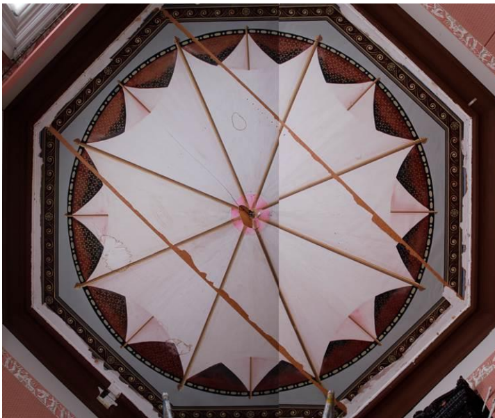
Kuva 41. Alkuperäinen koristemaalaus esiinoton jälkeen.
