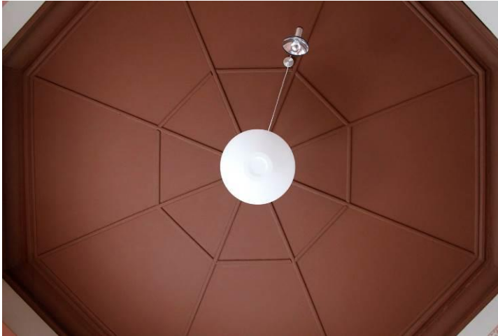
Kuva 40. Fredrikinkadun puoleisen kulmahuoneen katto työn alkaessa.
