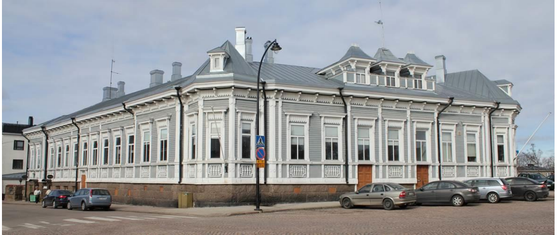
Kuva 1. Tanelinkulma Fredrikinkadun puolelta kuvattuna 2014.
