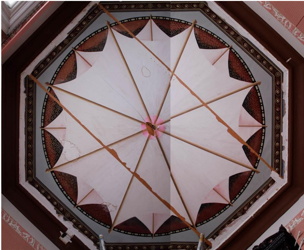
Kuva 21. Panoraama kulmahuoneen katosta.
