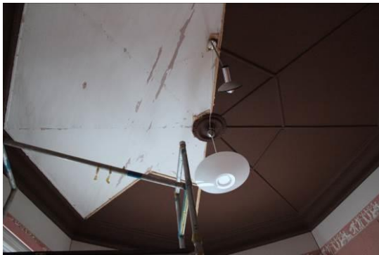
Kuva 14. Insuliittilevyjen purku.
