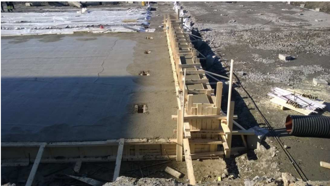
KUVA 27. Ankkurilaatta valettuna, jossa 4 varauskoloa ankkureiden kiristämistä varten
