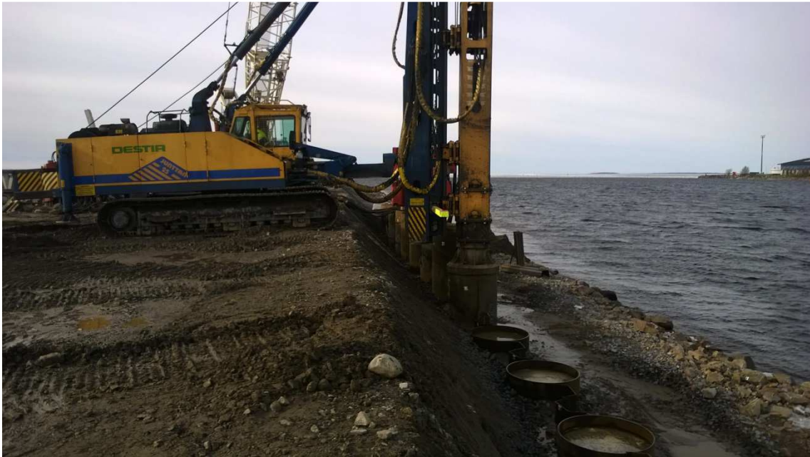
KUVA 23. Junttan PM 25 teräsputken lyönnissä
