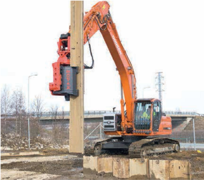
KUVA 18. Sivuotto vibralla varustettu kaivinkone (Movax tuoteluettelo 2013, 4)
