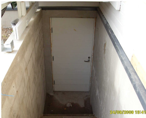
Kuva 5 Kellarin ulko-ovi asennettu
