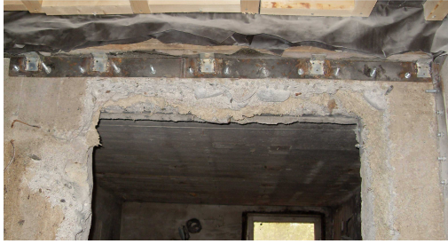
Kuva 13 Ovipalkki1 eteisen puolelta
