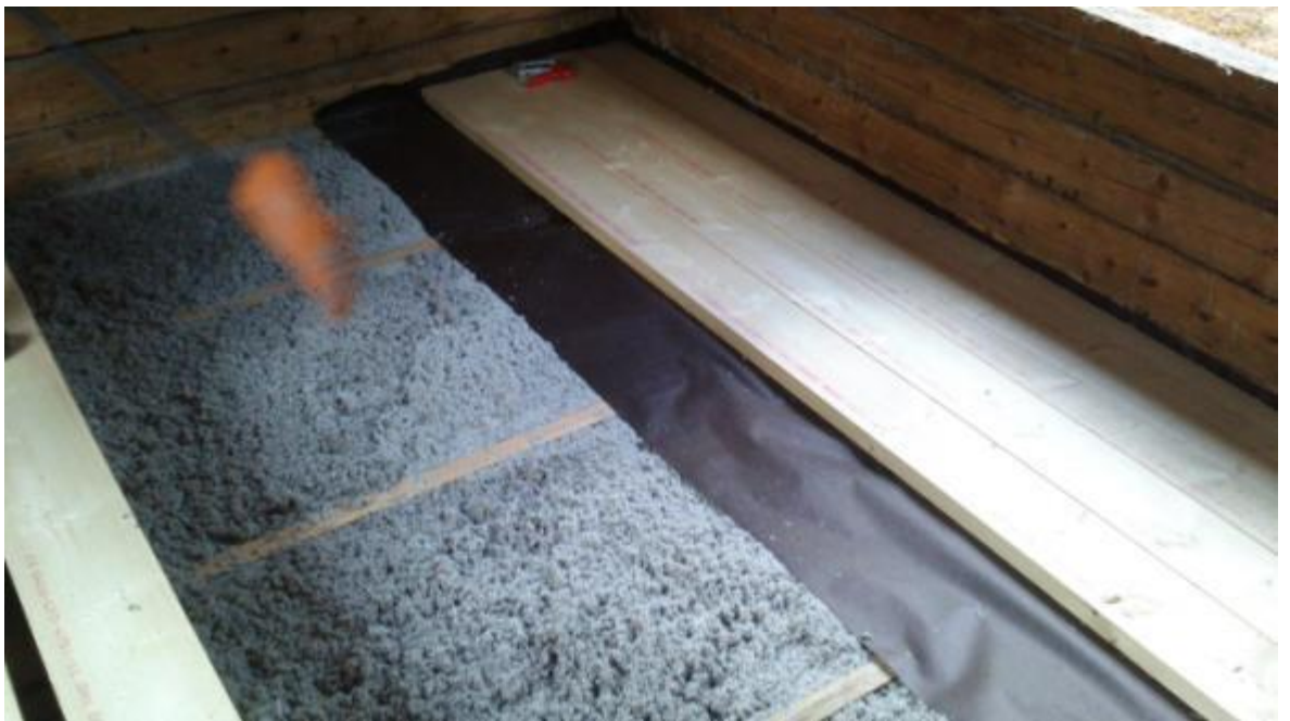
Kuvio 53. Lattialankkuja asennetaan.
