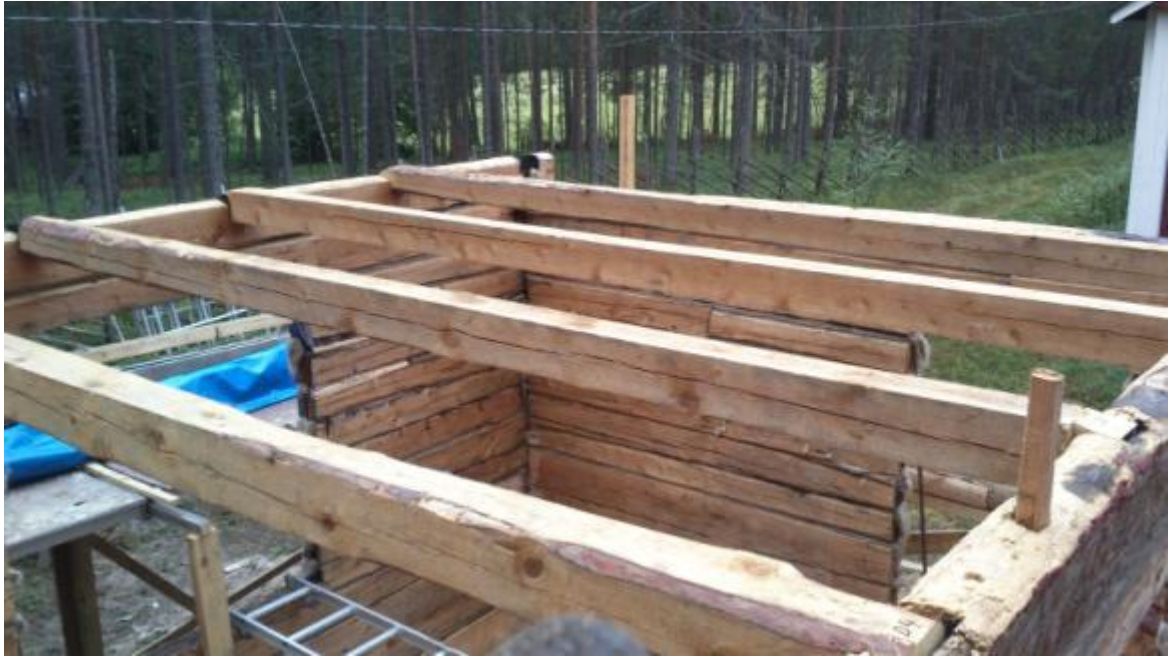
Kuvio 50. Yläpohjapalkit ovat loviliitoksilla kiinni sivuseinissä.
