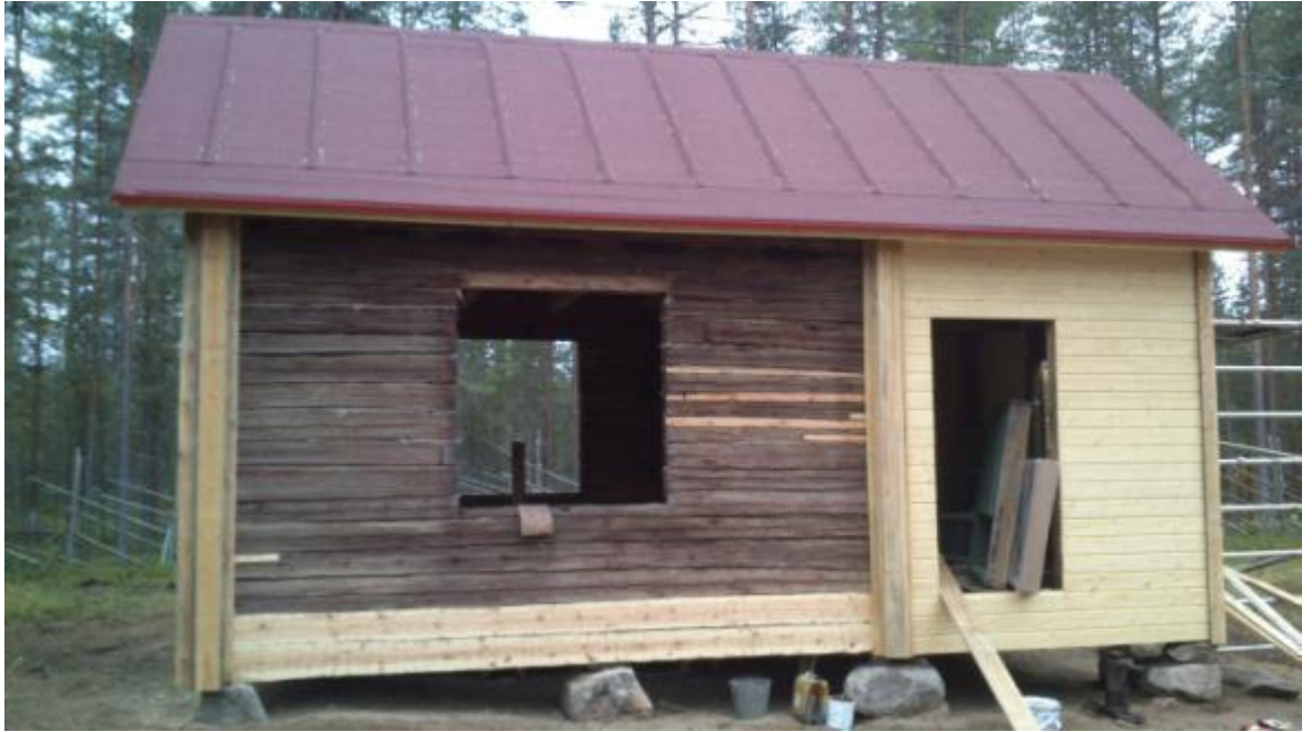
Kuvio 46. Ulkoverhous ja nurkkalaudat asennettuna.
