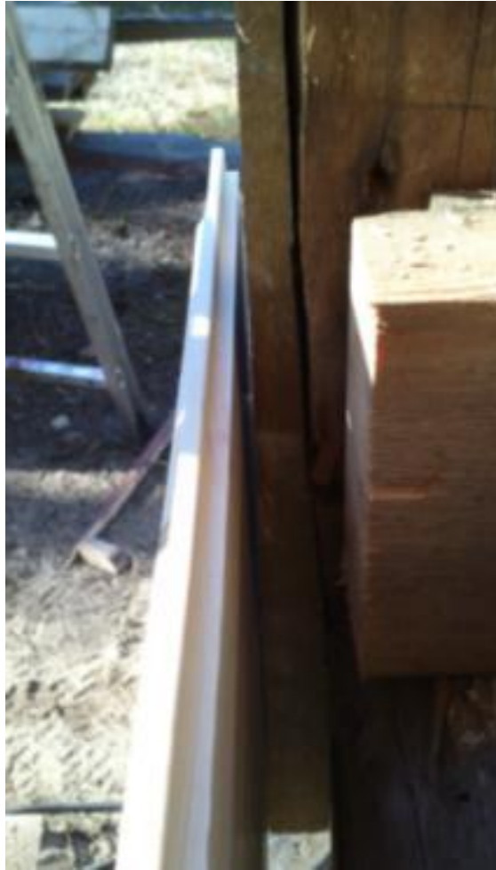
Kuvio 45. Kuistin ulkoverhouksen alle laitettiin kiiloja siistin ulkonäön aikaansaamiseksi.
