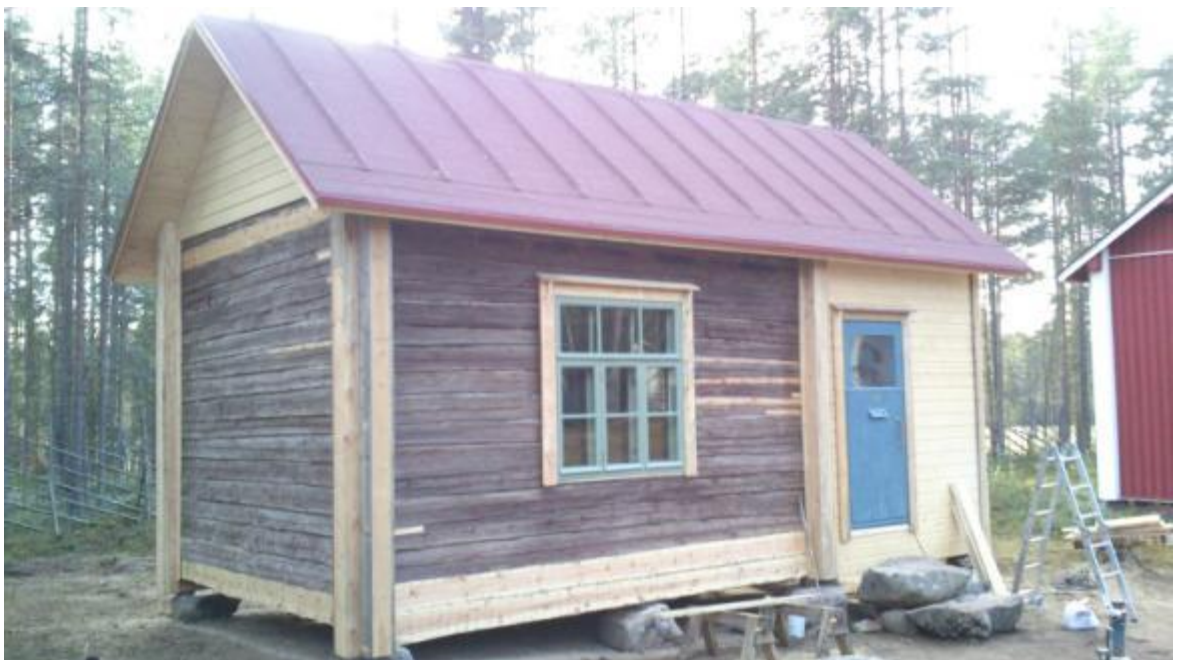
Kuvio 48. Ulkopuolelta valmis rakennus etupuolelta katsottuna.
