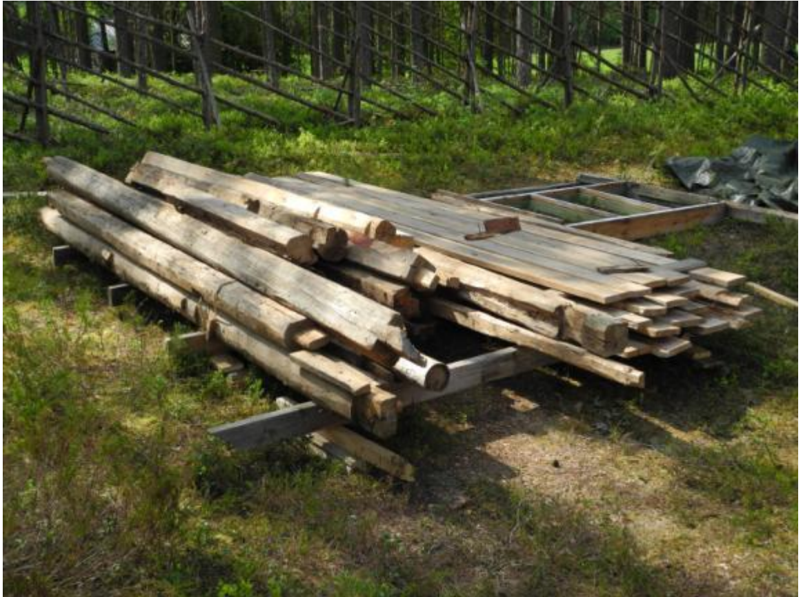
Kuvio 1. Projekti aloitettiin inventoimalla, mitä rakennusosia oli tallessa. Tässä on kuistin runko ja välikattolaudat puhdistettuna ja lajiteltuna rakennuspaikan viereen.
