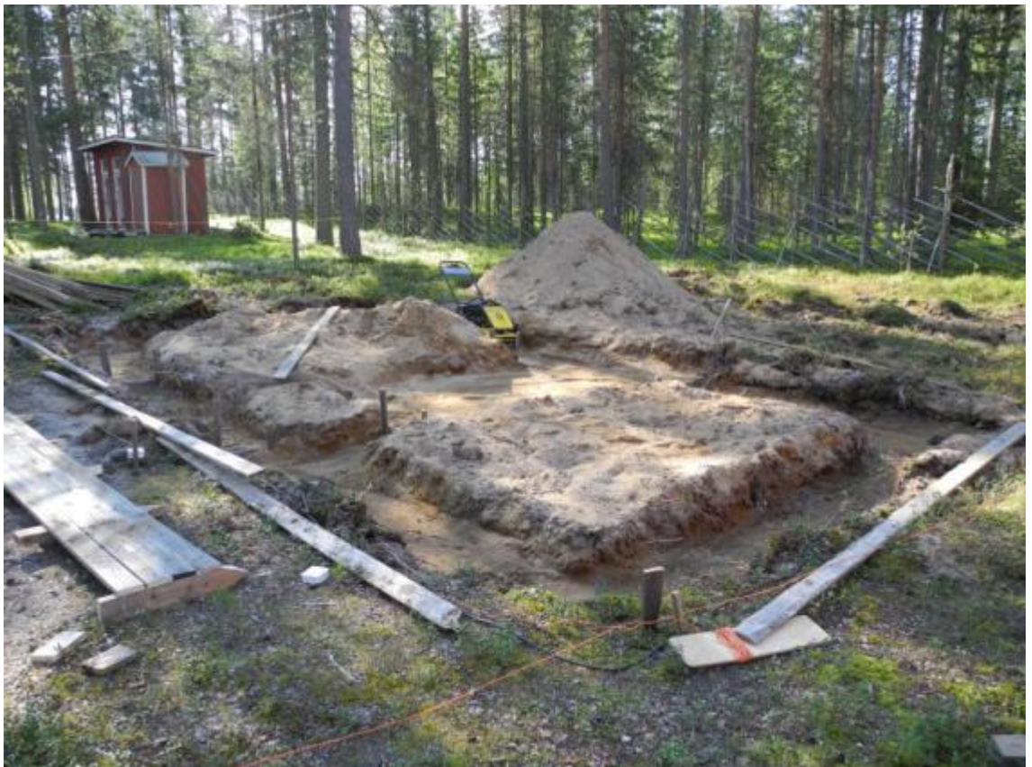
Kuvio 4. Kaivannon pohja tasattiin lapiolla ja täytettiin kovaksi.
