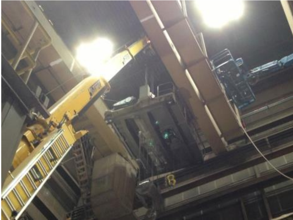
Kuva 17. Vanhan siltanosturin vaunun purku
