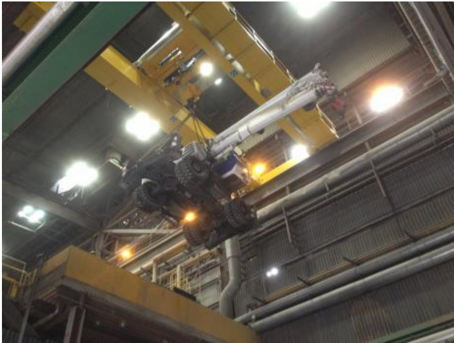
Kuva 37. Ensimmäinen nosto käynnissä nosturilla N2006
