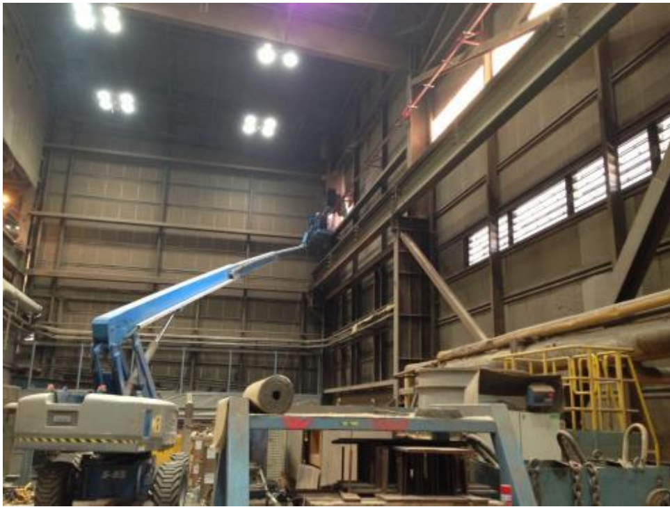
Kuva 13. Nosturin virtalinjan asennus
