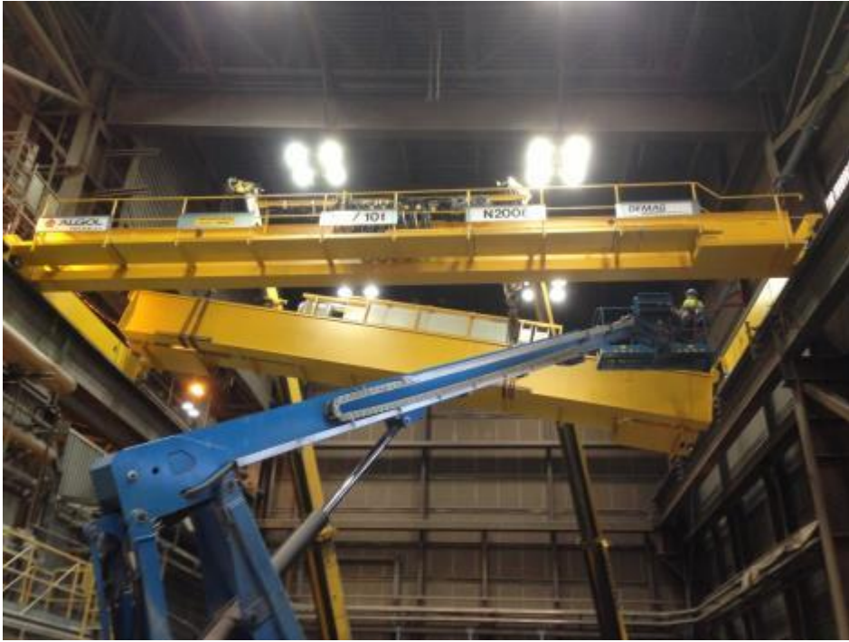
Kuva 25. Pääkannatinpalkin asennus jatkuu
