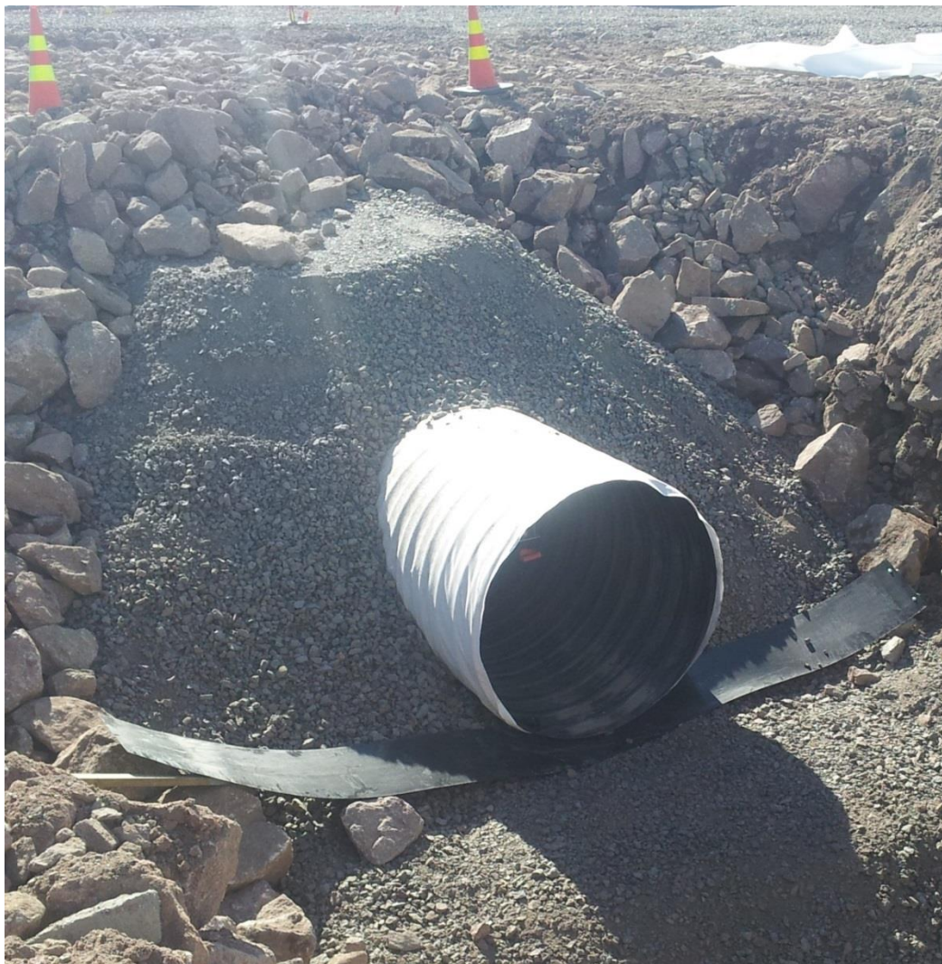
KUVA 21. Lopputäyttömateriaalia alkutäytön päällä. Kuva Antti Nykänen 2013
