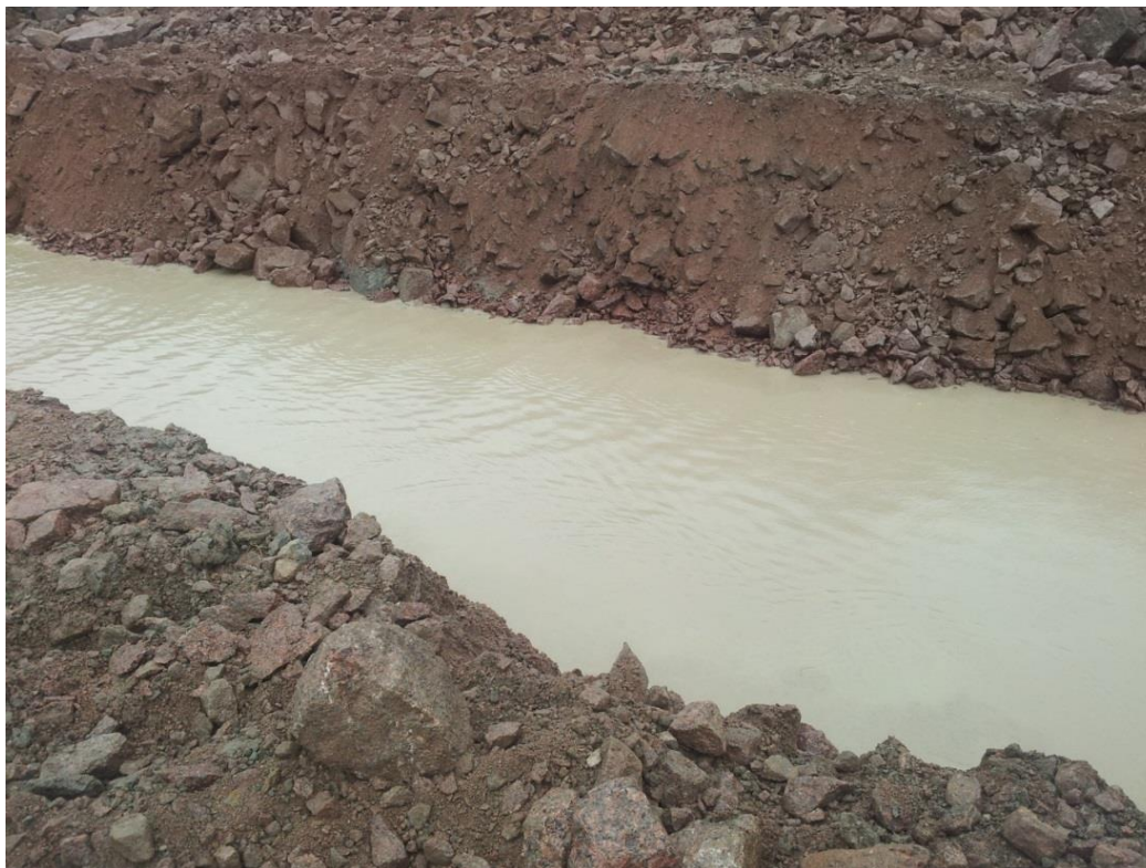
KUVA 2. Vettä rumpukaivannossa. Kuva Antti Nykänen 2013
