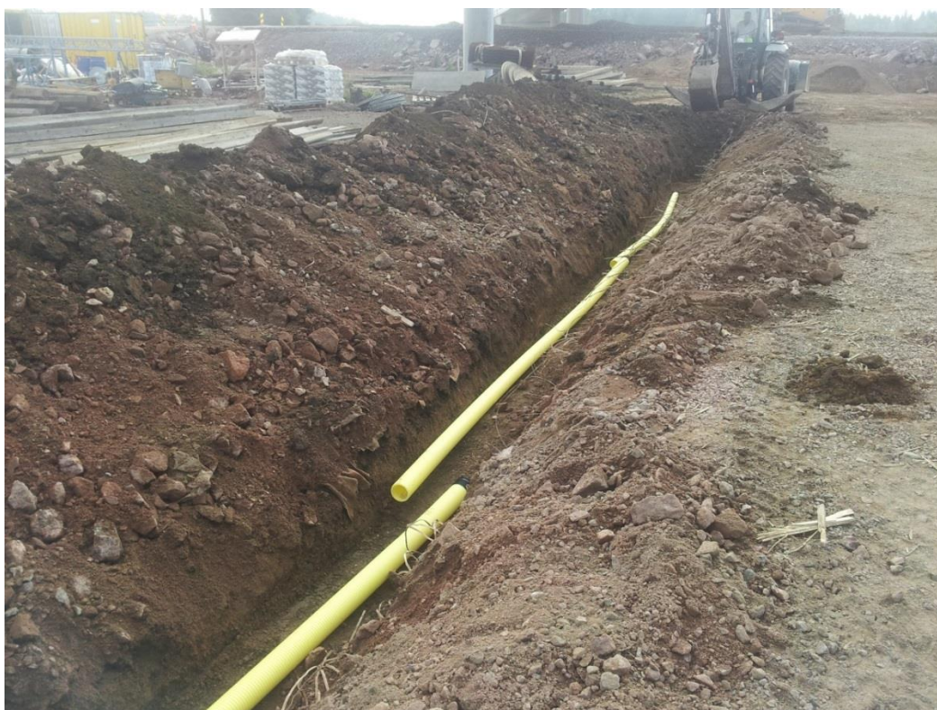
KUVA 5. Telematiikkakaapelin suojaputkikaivanto liikennealueen ulkopuolella. Kuva Antti Nykänen 2013
