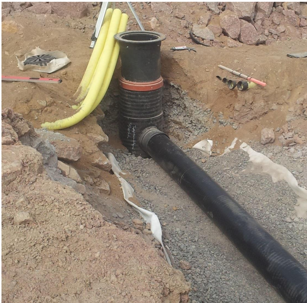
KUVA 25. Hulevesiputki liitettynä muoviseen hulevesikaivoon. Kuva Antti Nykänen 2013
