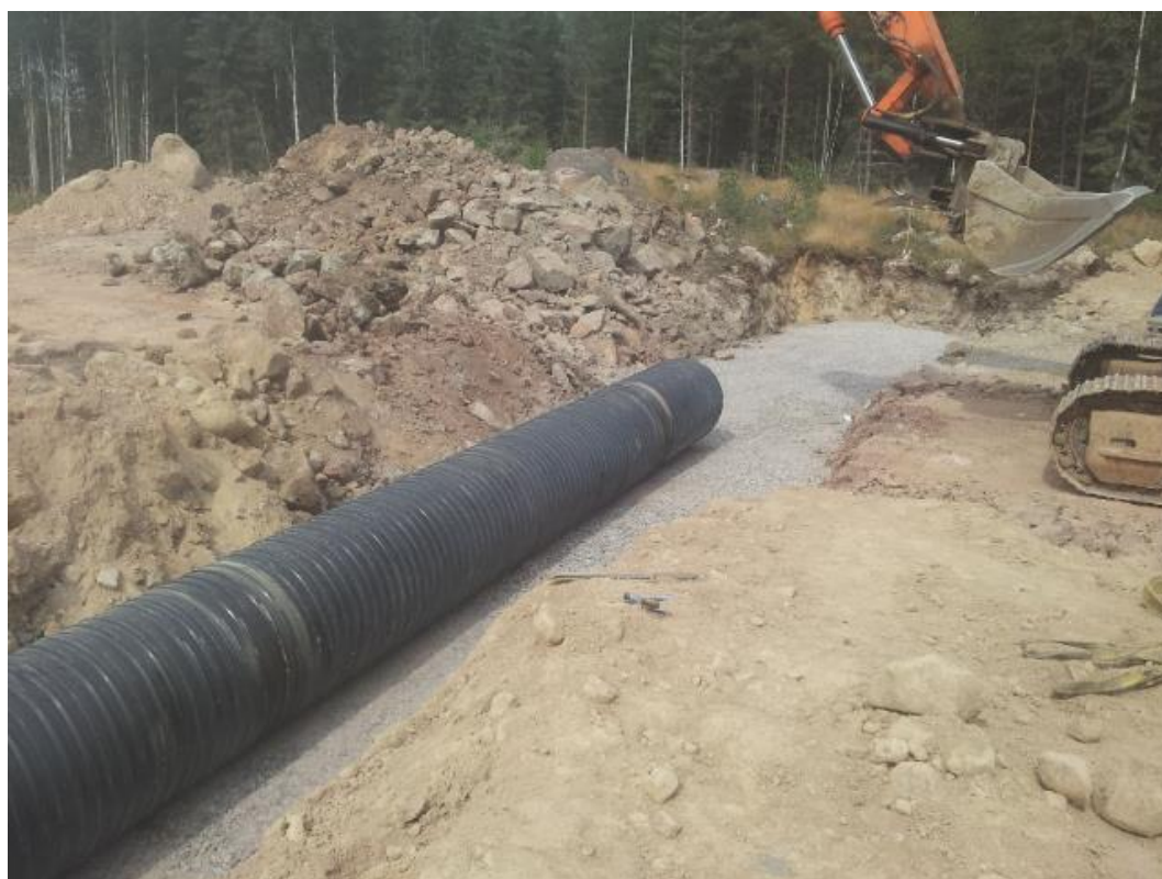
KUVA 31. Rumpu asennettuna kaivantoon. Kuva Antti Nykänen 2013
