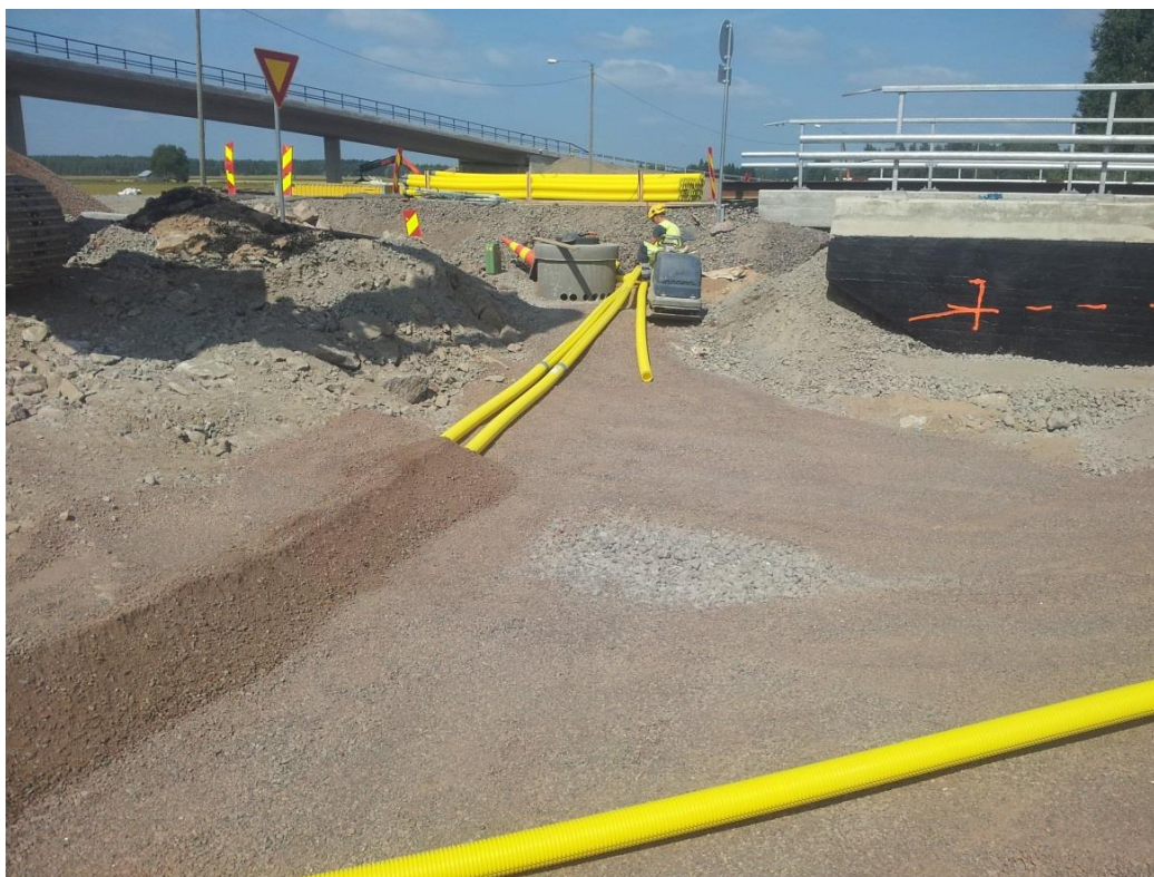
KUVA 18. Alkutäytön tekoa murskeesta muovisille kaapelinsuojaputkille. Kuva Antti Nykänen 2013
