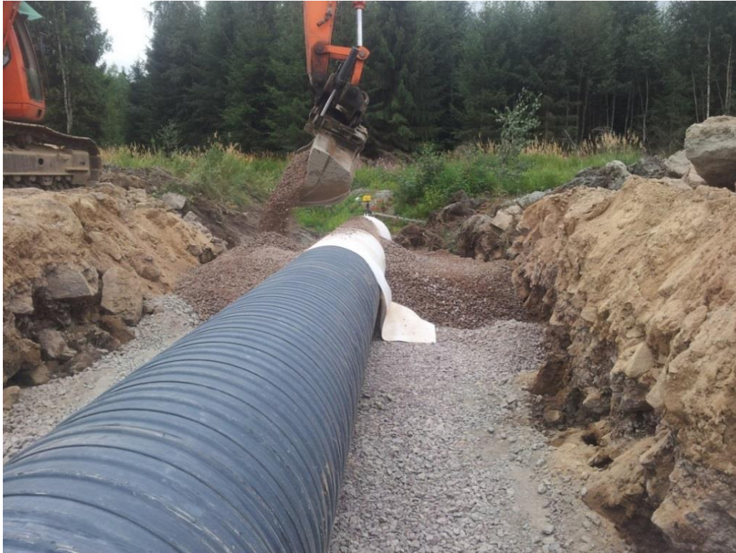
KUVA 17. Alkutäytön tekoa rumpuputkelle. Kuva Antti Nykänen 2013
