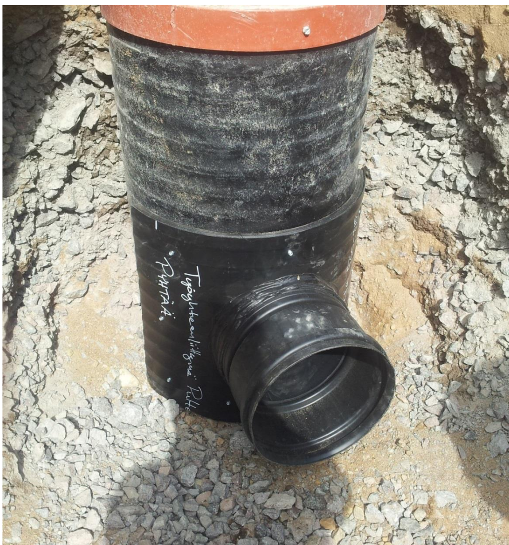
KUVA 23. Jälkiliitossatula asennettuna muoviseen hulevesikaivoon. Kuva Antti Nykänen 2013
