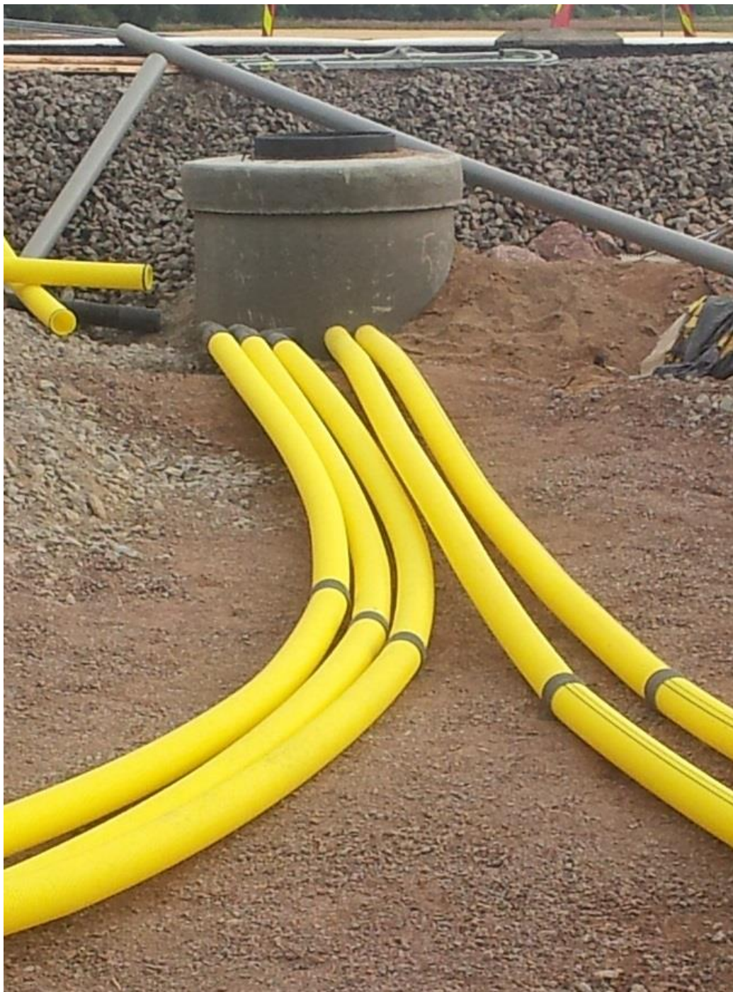
KUVA 34. A-lujuusluokan kaapelinsuojaputkea asennettuna asennusalustalle liikenne- alueella. Kuva Antti Nykänen 2013
