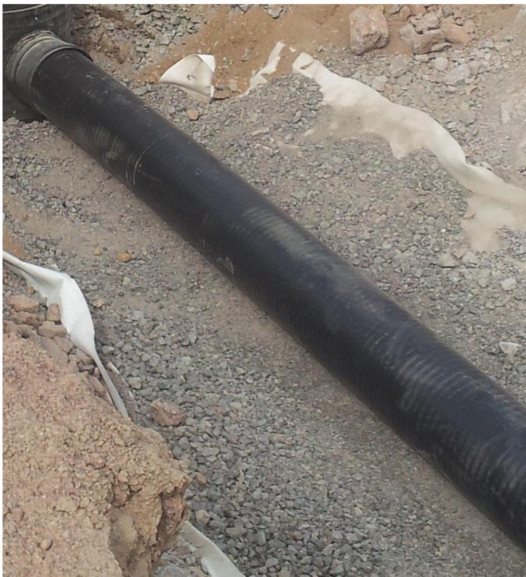
KUVA 22. Muovinen hulevesiviemäriputki asennettuna asennusalustan päälle. Kuva Antti Nykänen 2013
