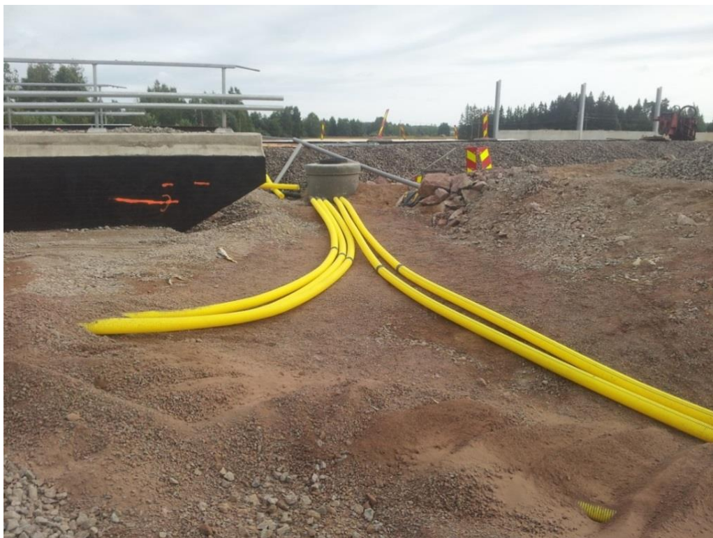
KUVA 14. Kaapelien suojaputket asennettuina murskeesta tehdylle asennusalustalle.
