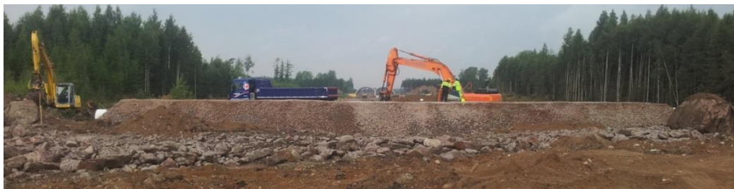
KUVA 20. Valmis alkutäyttö rumpuputkelle. Kuva Antti Nykänen 2013
